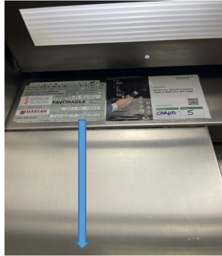
Ilustración 38. Etiqueta de inspección de Ascensores. EP
