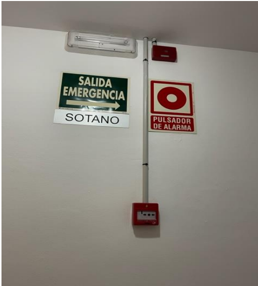
Ilustración 31. Acceso al sótano. EP
