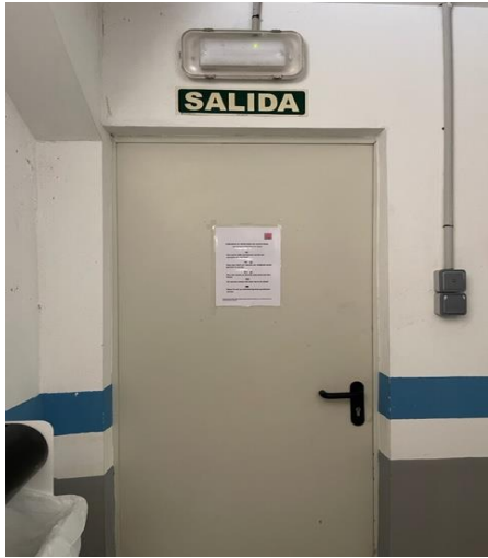
Ilustración 24. Puerta de salida de emergencia. EP
