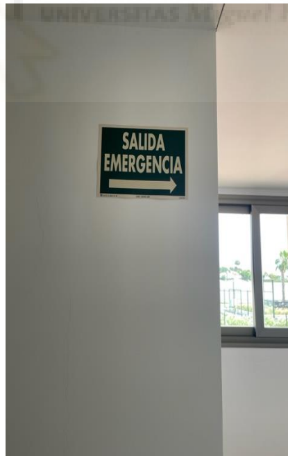
Ilustración 47. Señalización de salida de emergencia. EP
