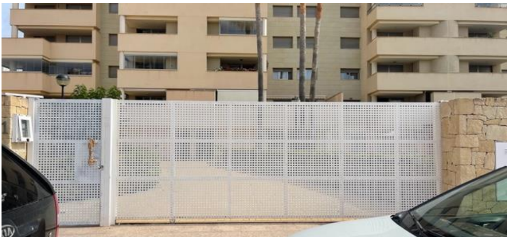
Ilustración 5. Puerta N°1 de acceso al Edificio. EP
