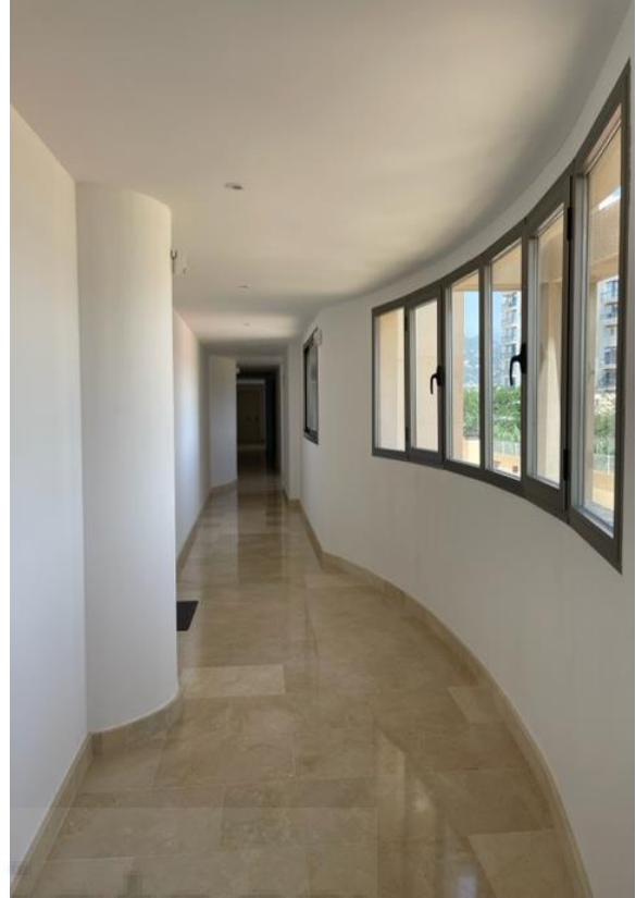
Ilustración 45. Ventanas en los pasillos. EP
