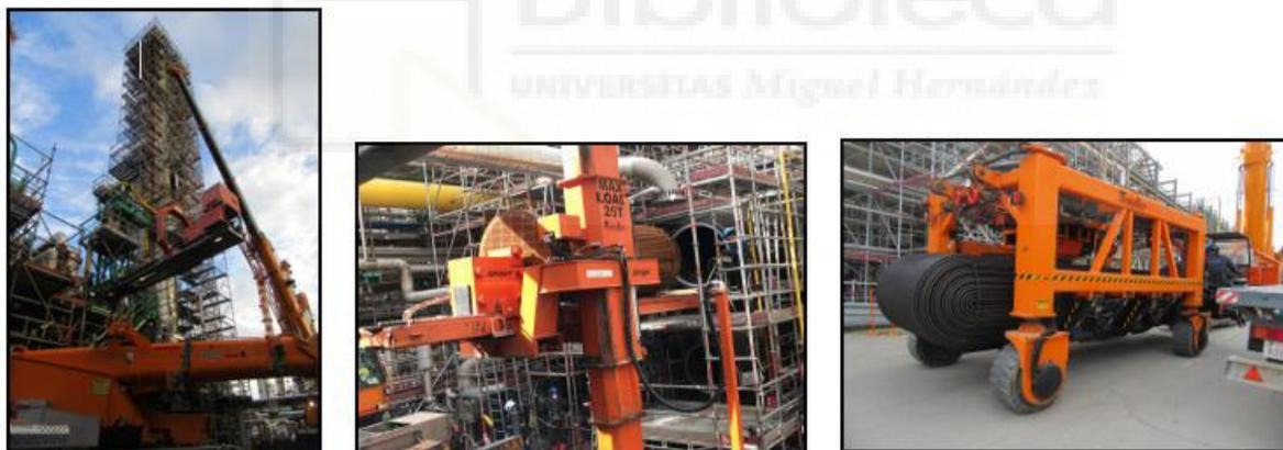
Fig. Nº 2 Extracción, Inserción y transporte de intercambiadores de calor.
