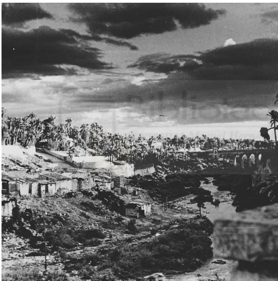
[Fotografia] d'anònim. (Barri de La Teulera, 1980) Càtedra Pedro Ibarra, Elx. Espanya.
