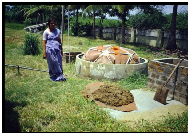
Ilustración 3. Ejemplo de digester rudimentario alimentado por estiércol en la India.
