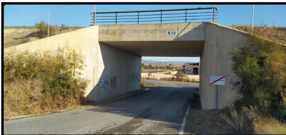
Ilustración 66. Aprovechamiento de paso inferior para salvar línea de ferrocarril.
