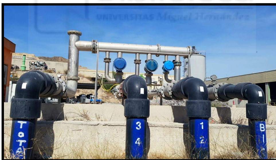
Ilustración 45. ERM que permite regular el aporte de cada una de las líneas de biogás.
