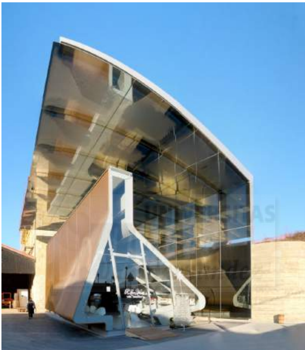
Figura 122. Estructura realizada por Zaha Hadid para las Bodegas López de Heredia, 2002.
