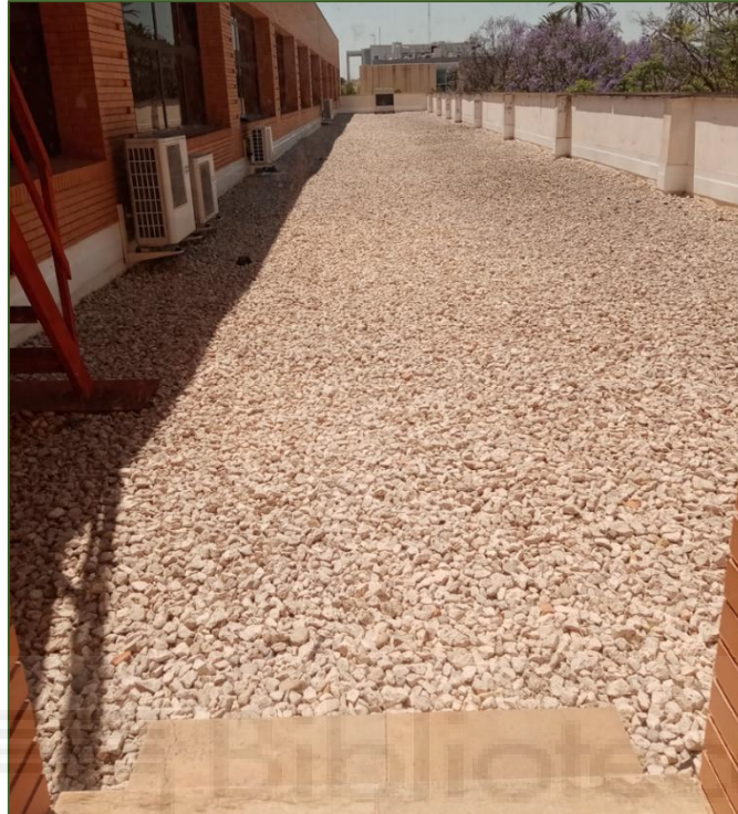
Figura 4. Fotografía del acceso desde la planta primera a la cubierta en la que se plantea la instalación del tejado verde. Fuente: elaboración propia.
