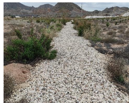
Figura 4: Canal de drenaje, con relleno de gravas gruesas. Este influye sobre la distribución de la vegetación. Fuente: Elaboración propia.
