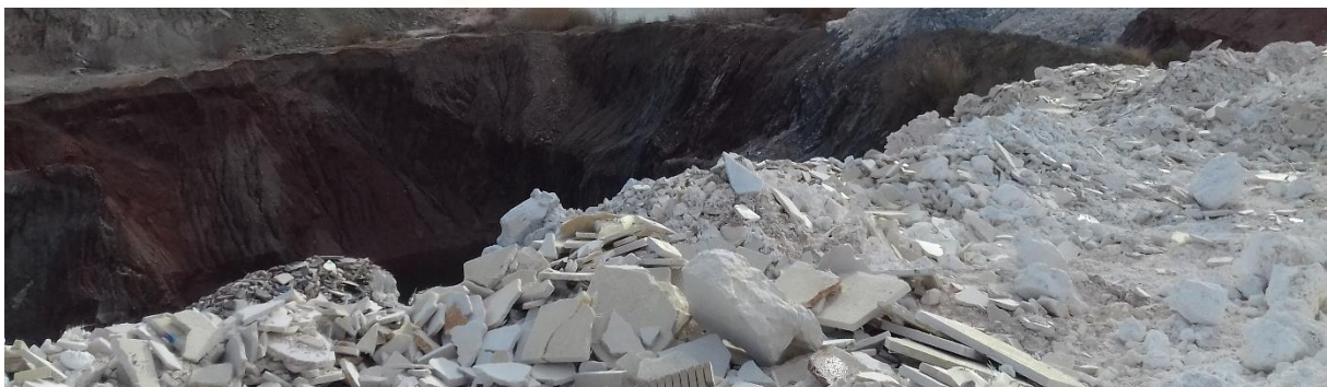
Figura 2: Residuos inertes (lodo generado en el proceso de corte y casquillos) empleados en el relleno de los huecos mineros para llevar a cabo la restauración. Fuente: Levantina, 2019.
