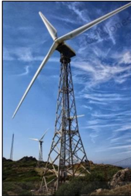
Figura 28: Torre de celosía. FUENTE: [20].
