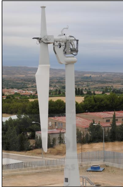
Figura 26: Aerogenerador monopala. FUENTE [18].
