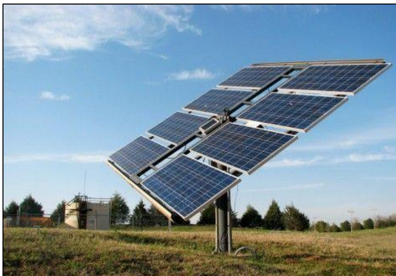
Figura 45: Estructuras con seguimiento solar. FUENTE [33].
