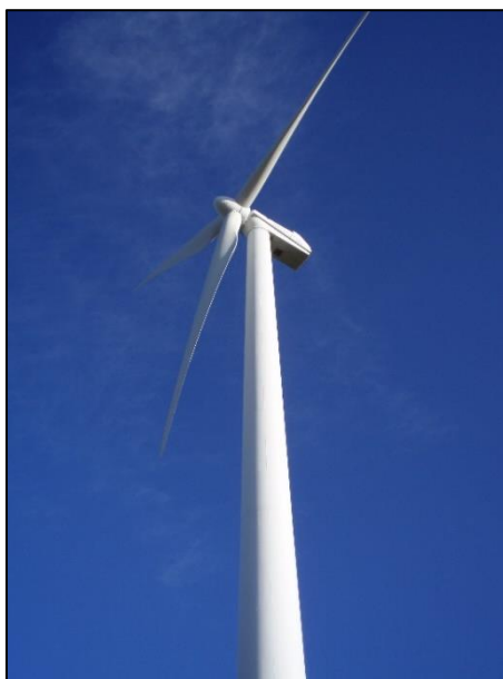
Figura 29: Torres tubulares. FUENTE [21].
