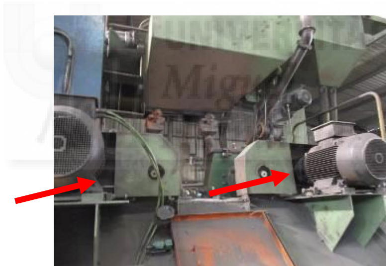
Imagen 39. Aberturas en zona de transmisión
