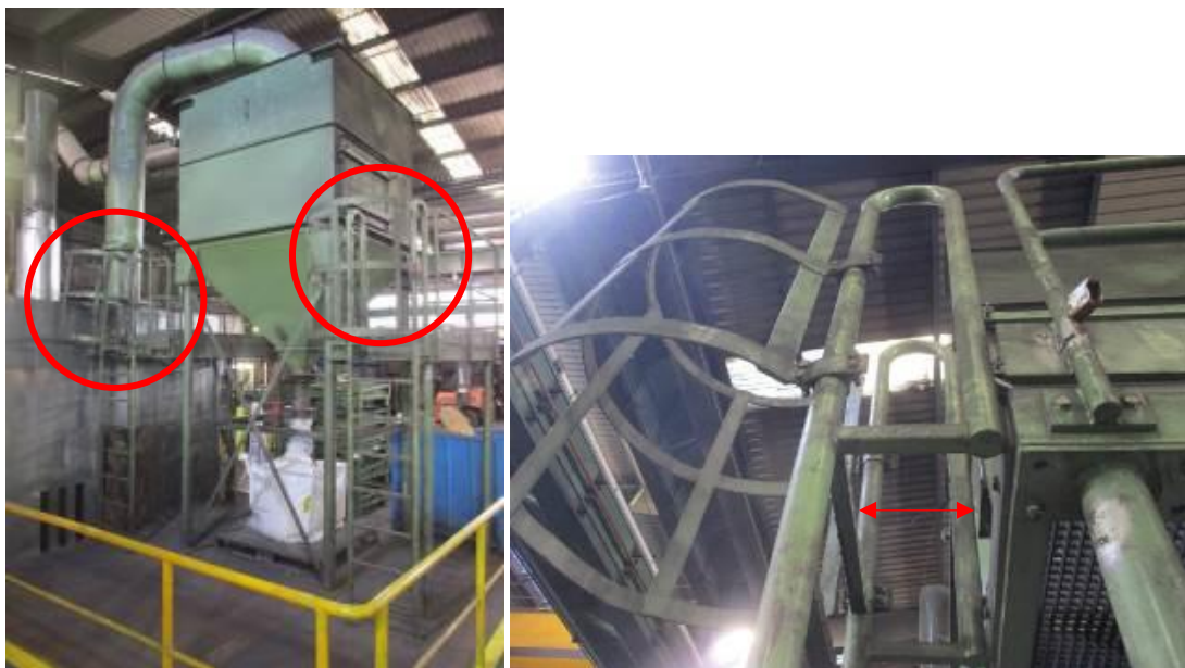
Imagen 11. Acceso a pasarelas aspiración
