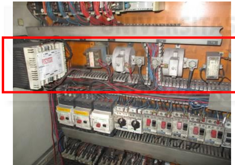
Imagen 51. Partes en tensión accesibles
