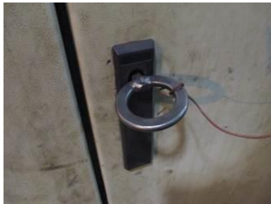
Imagen 51. Partes en tensión accesibles
