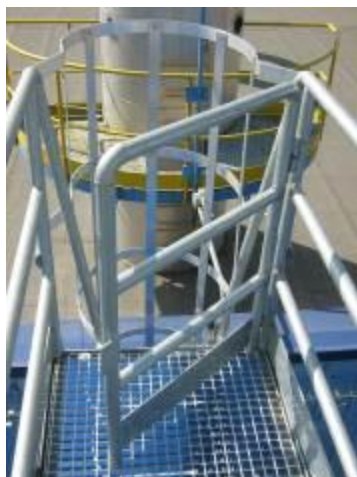
Imagen 13. Ejemplo puerta en la zona de llegada a pasarela
