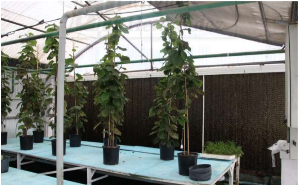
Figura 13: Interior de un invernadero. Se aprecia al fondo el panel del sistema de refrigeración o cooling. Fuente propia
