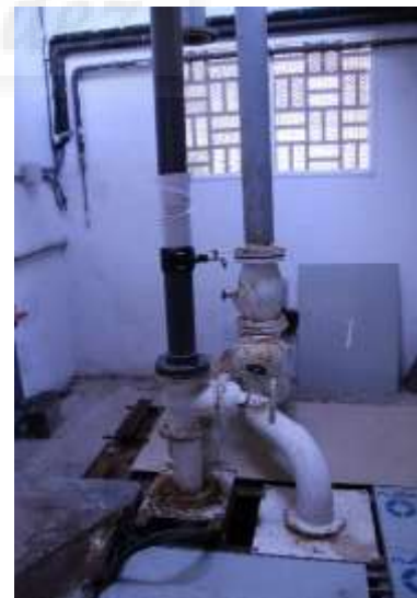
Figura 5: Punto de extracción del pozo de abastecimiento nº2 de Moncada. Fuente: propia.
