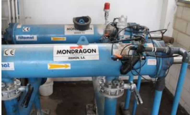
Figura 3: Filtro de partículas sólidas en suspensión del cabezal de riego. Fuente: propia.
