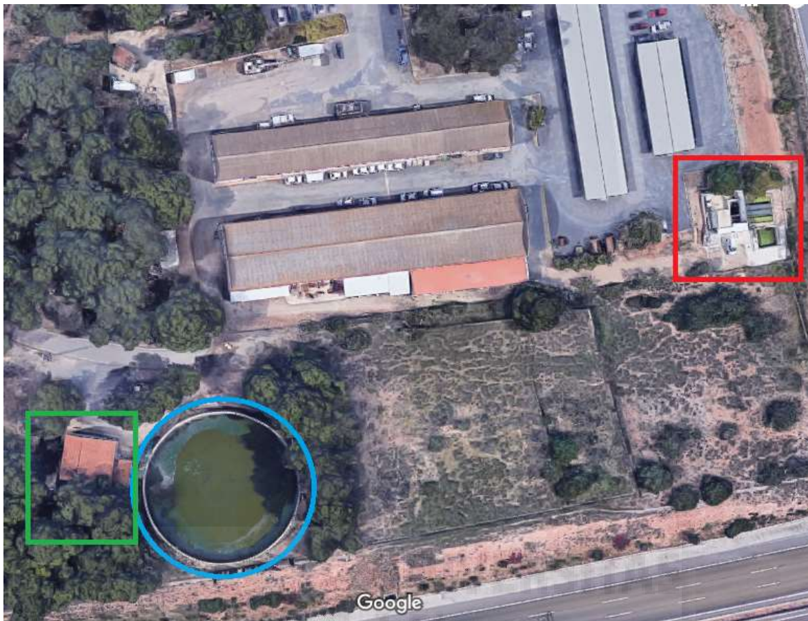
Figura 12: Detalle del IVIA en vista aérea. Se muestra la cisterna de riego (círculo azul), el cabezal de riego (Cuadro verde), y la planta depuradora (cuadro rojo).
