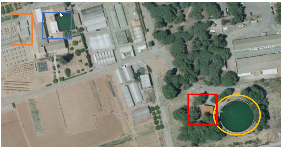
Figura 8:Detalle del IVIA en vista aérea. Se señala en azul el pozo, en naranja la planta de ósmosis, en amarillo la balsa de riego, y en rojo el cabezal de riego. Fuente: geoportal.moncada.es
