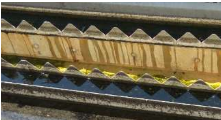
Figura 16: Detalle de una balsa de decantación. Fuente propia.
