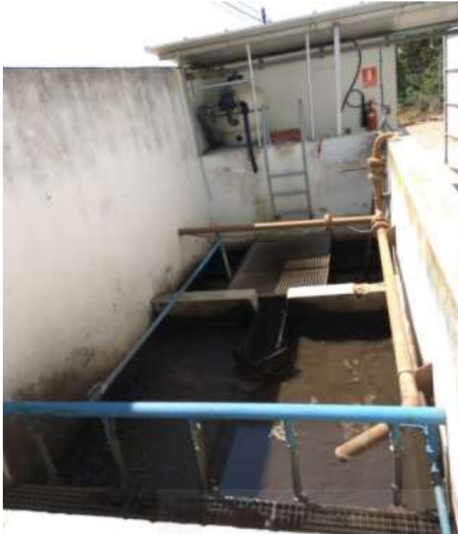
Figura 14: Cisterna de aireación de fangos. Se elimina la carga orgánica del agua. Fuente propia.
