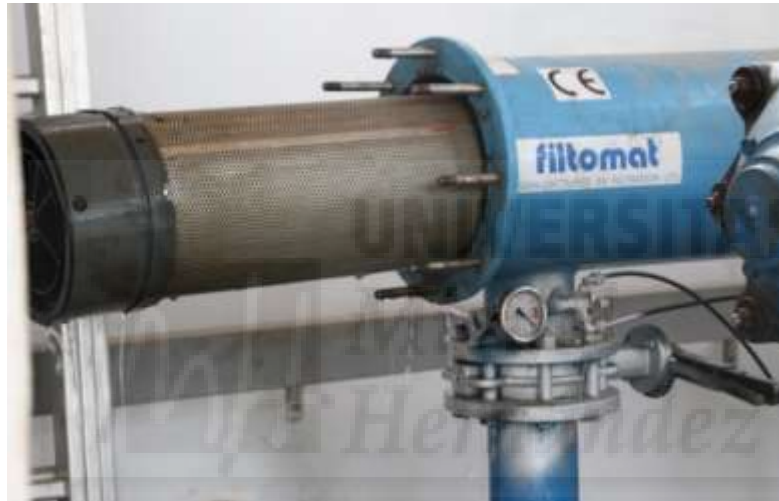
Figura 4: Detalle del filtro de partículas sólidas del cabezal de riego. Fuente: propia.
