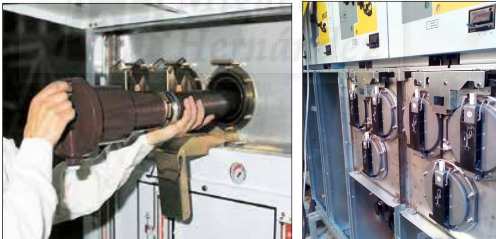
Fig. 16 y 17: Cambio de un fusible FS6
