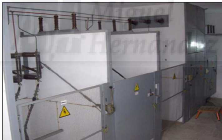
Fig. 9: CT al aire o convencional
