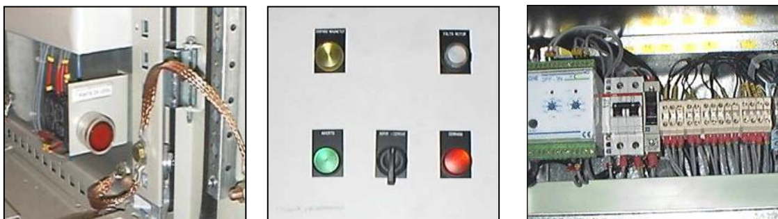
Fig. 26: Los tres pasos a seguir en el bloqueo eléctrico
