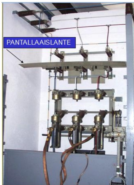
Fig. 27: Ejemplo de bloqueo físico con pantallas
