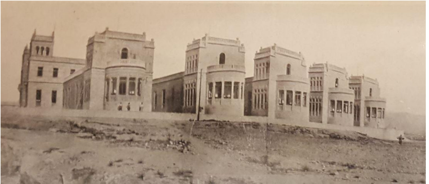
El hospital provincial en construcción. Fachada lateral. Fuente: Diputación Provincial 58 .
