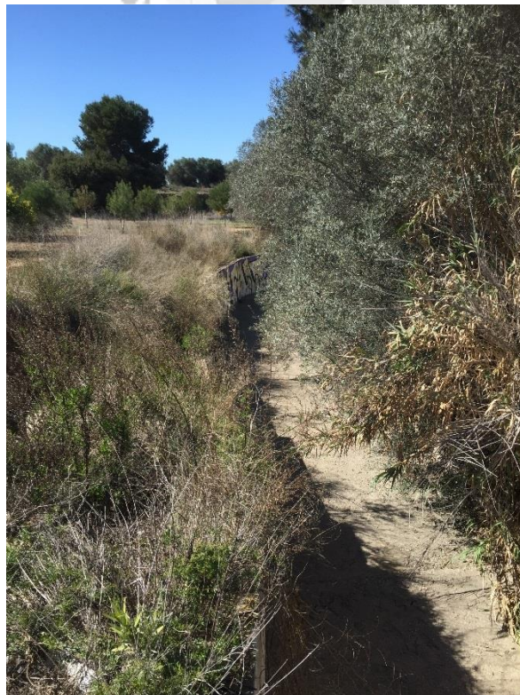
7.- Canal existente para aguas pluviales situado en la zona norte de la parcela.
