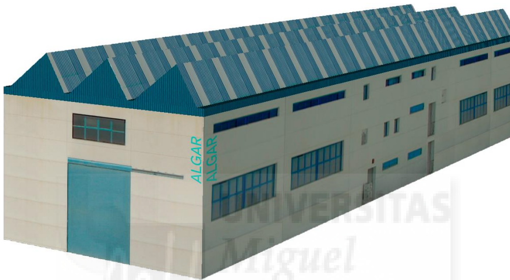
Fig. 9 Identificación Edificio Algar, pintura vinil-acrílica con acabado satinado mate
