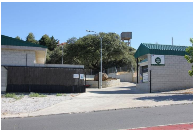
Figura 24 Imagen Puerta de entrada al Punto Limpio de Cotos de Monterrey
