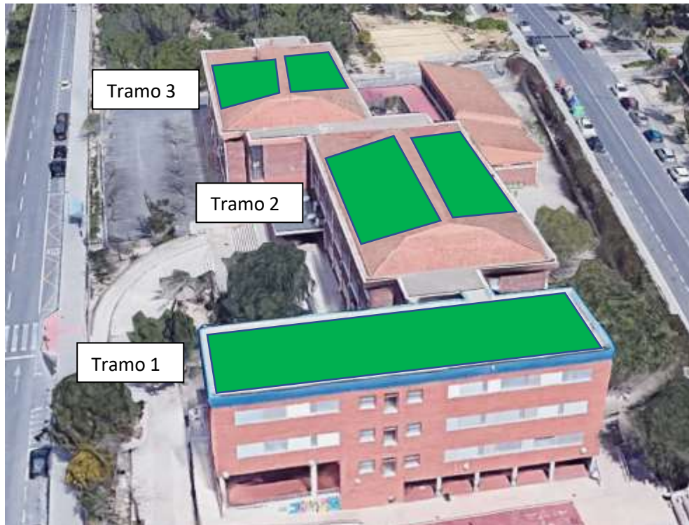
▪ Imagen 22: Zona ubicación instalación FV
