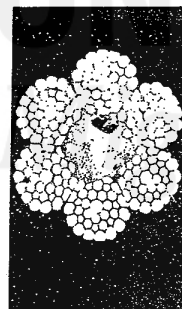
Cliché 7 - Ejemplo de un cable que presenta una fuerte corrosión interna. Es de notar la desaparición de los alambres de relleno de los cordones en contacto con el alma (observación posible al torcer el cable). Observar también una fuerte constricción y una deformación de los alambres de los cordones. El cable debe ser retirado inmediatamente.
