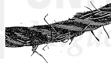
Cliché 21 - Ejemplo de un cable salido de una garganta de poleas y atascado. Esto ha producido una deformación y rotura de alambres así como la rotura parcial de cordones. El cable debe ser retirado inmediatamente.
