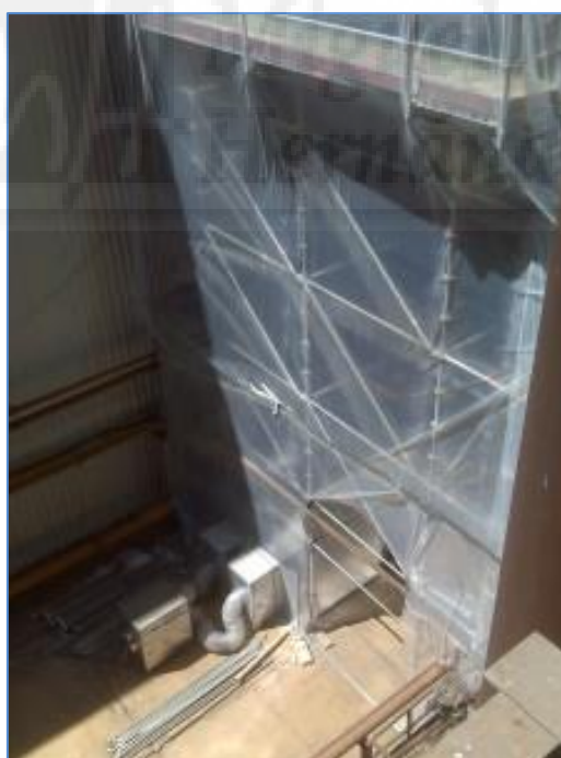
Figura 4. 20. Burbuja de contención. Aislamiento zona de trabajo MCA.[32]
