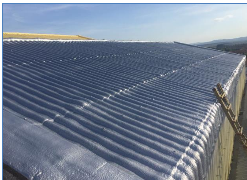
Figura 4. 3. Estabilización de MCA. Estado final.
