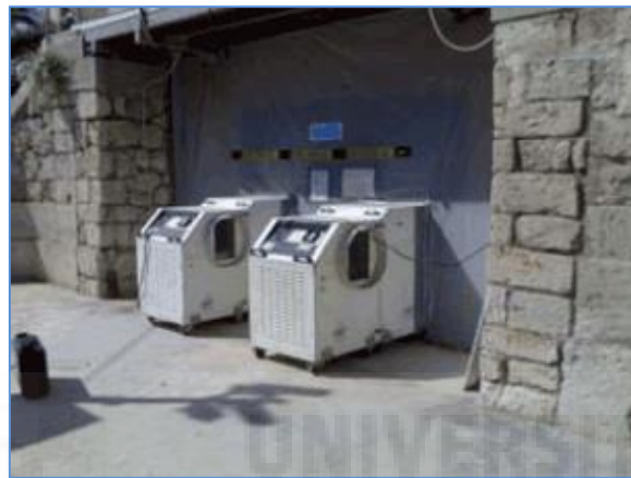
Figura 4. 21. Extractores para mantener presión negativa.
