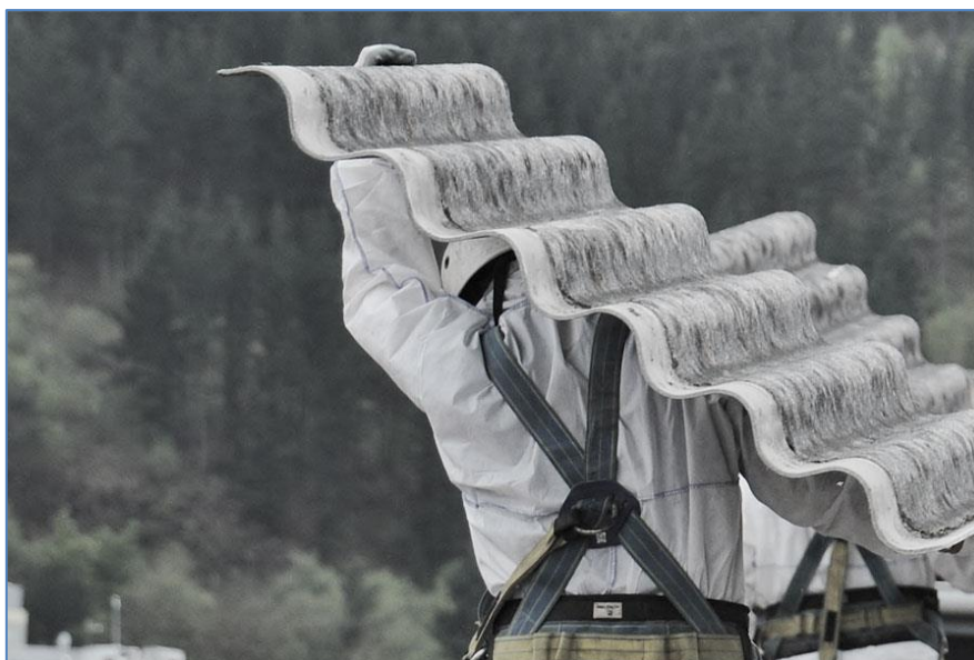
Figura 4. 5. Desamiantado.[29]
