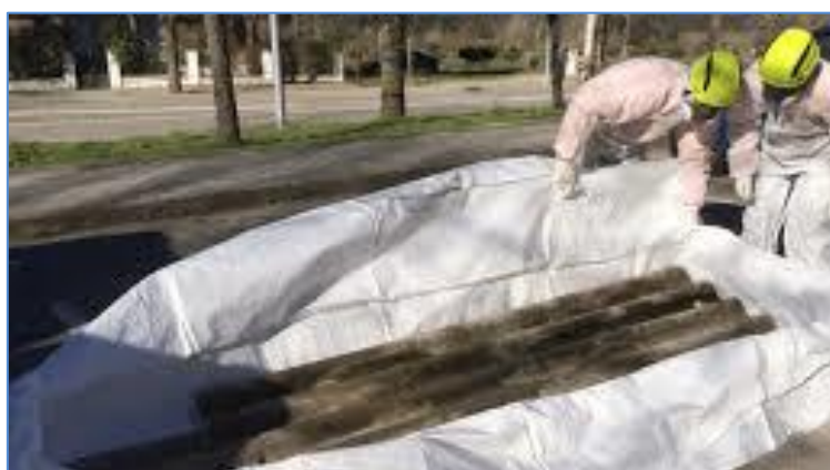
Figura 5. 41. Ejemplo introducción placas en sacas.
