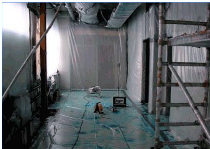
Figura 4. 19. Barreras críticas. Aislamiento zonas de trabajo MCA.[31]
