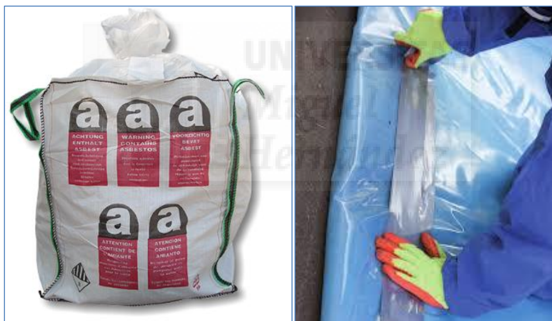
Figura 4. 6. Embalaje de residuos de amianto.
