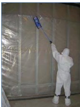
Figura 5. 17. Ejemplo cerramiento con láminas plásticas.
