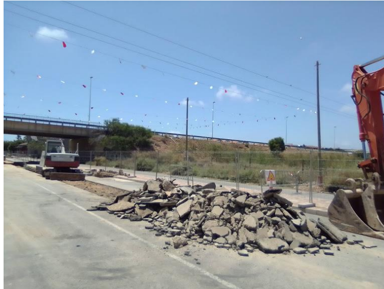
Ilustración 3 Corte y demolición de pavimento asfáltico. Fuente: Elaboración propia.
