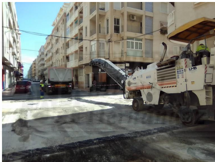
Ilustración 9 Fresado de pavimento asfáltico. Fuente: Elaboración propia.
