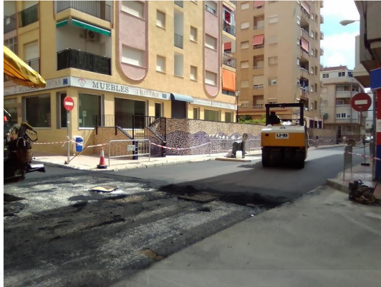
Ilustración 10 Reposición de pavimento asfáltico. Fuente: Elaboración propia.
