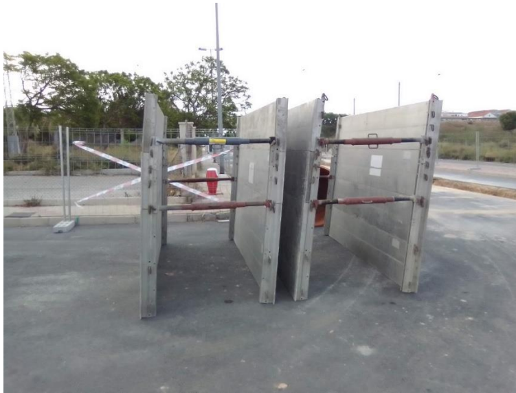
Ilustración 16 Módulos de entibación ligera con paneles de aluminio. Fuente: elaboración propia.
