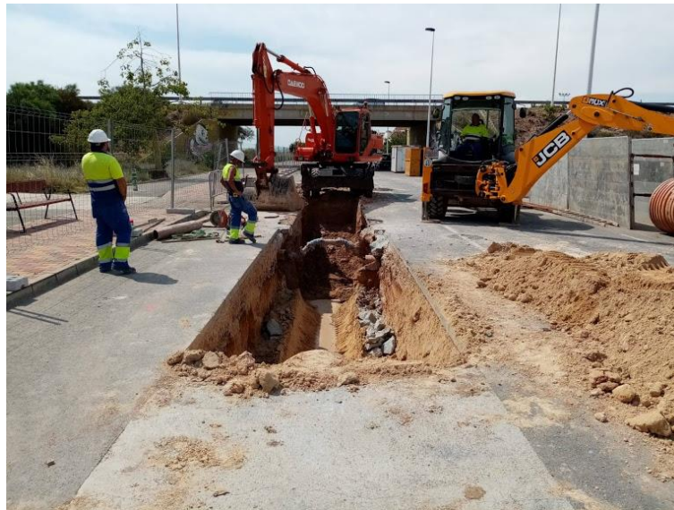
Ilustración 4 Excavación de zanjas. Fuente: Elaboración propia.
