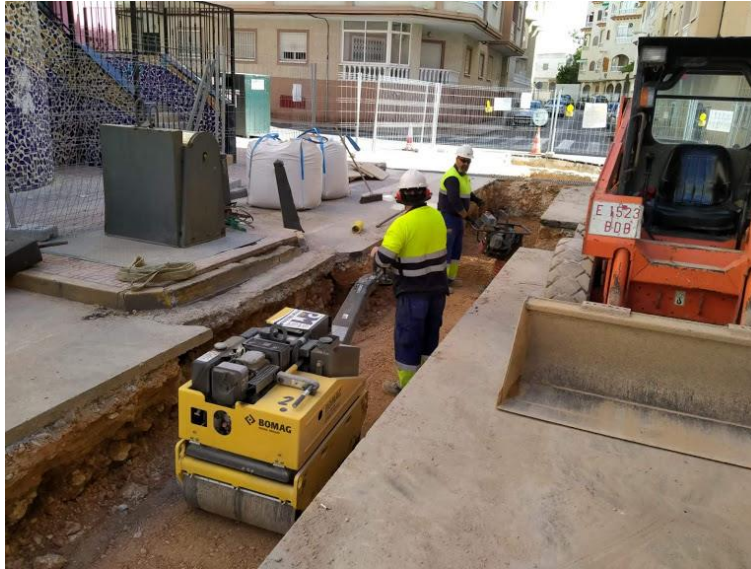
Ilustración 7 Relleno y compactado de zanjas. Fuente: Elaboración propia.
