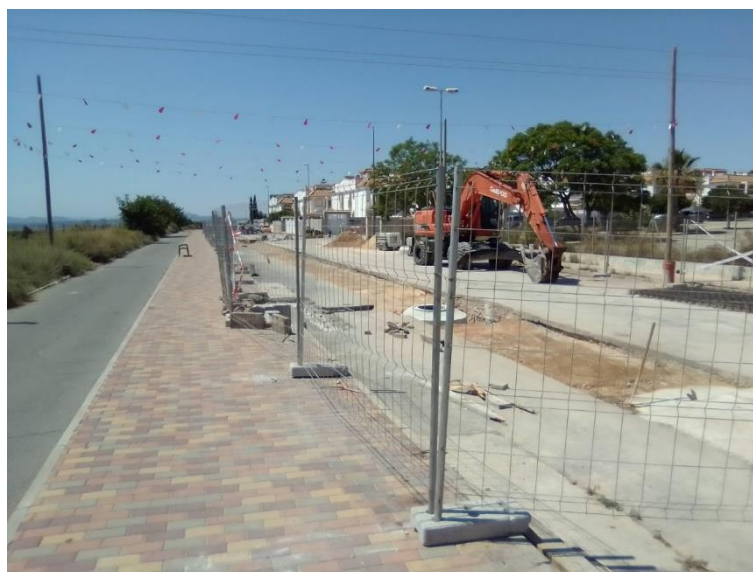
Ilustración 14 Vallado perimetral de obra con valla de pie de hormigón. Fuente: Elaboración propia.
