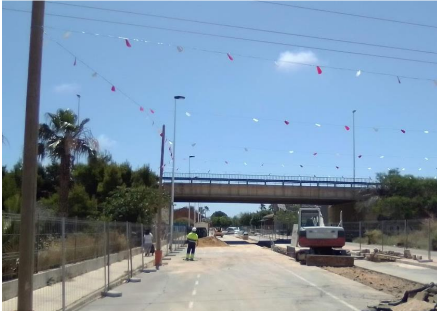
Ilustración 22 Maquinaria trabajando debajo de línea eléctrica con limitación de movimientos mediante pórtico de señalización de altura máxima. Fuente: elaboración propia.
