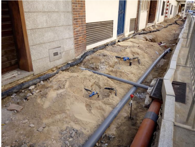
Ilustración 5 Montaje de tuberías. Fuente: Elaboración propia.
