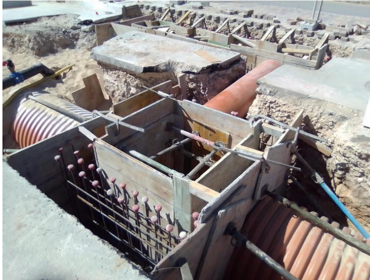
Ilustración 6 Ejecución de arqueta de registro. Fuente: Elaboración propia.
