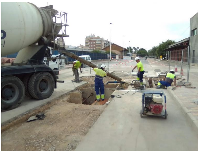
Ilustración 8 Labores de hormigonado. Fuente: Elaboración propia.
