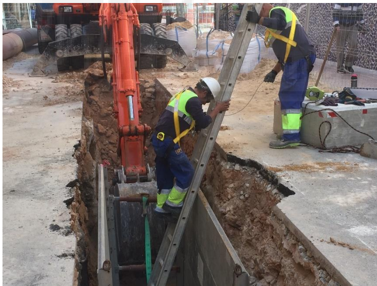
Ilustración 19 Trabajador haciendo uso de arnés de seguridad y cable anticaída anclado a lastre de hormigón. Fuente: elaboración propia.
