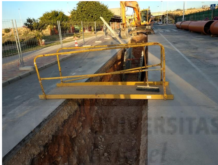
Ilustración 20 Pasarela de paso en zanjas. Fuente: elaboración propia.
