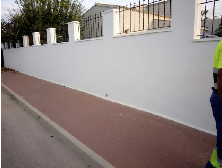
Ilustración 11 Reposición de pavimento de aceras. Fuente: Elaboración propia.
