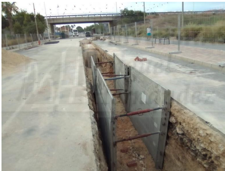
Ilustración 17 Entibación de zanjas. Fuente: elaboración propia.
