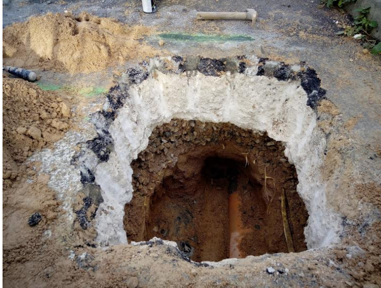
Ilustración 2 Ejecución de cata para localización de servicios afectados. Fuente: Elaboración propia.
