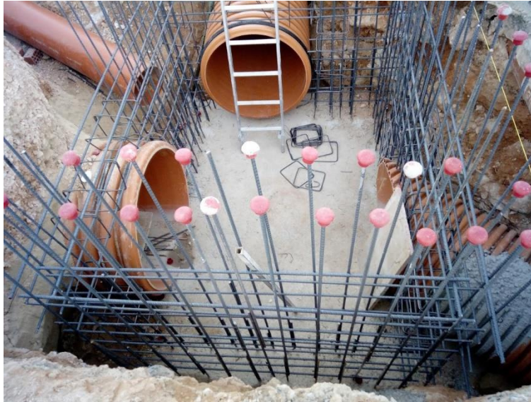
Ilustración 21 Protección de armaduras con setas protectoras de plástico. Fuente: Elaboración propia.
