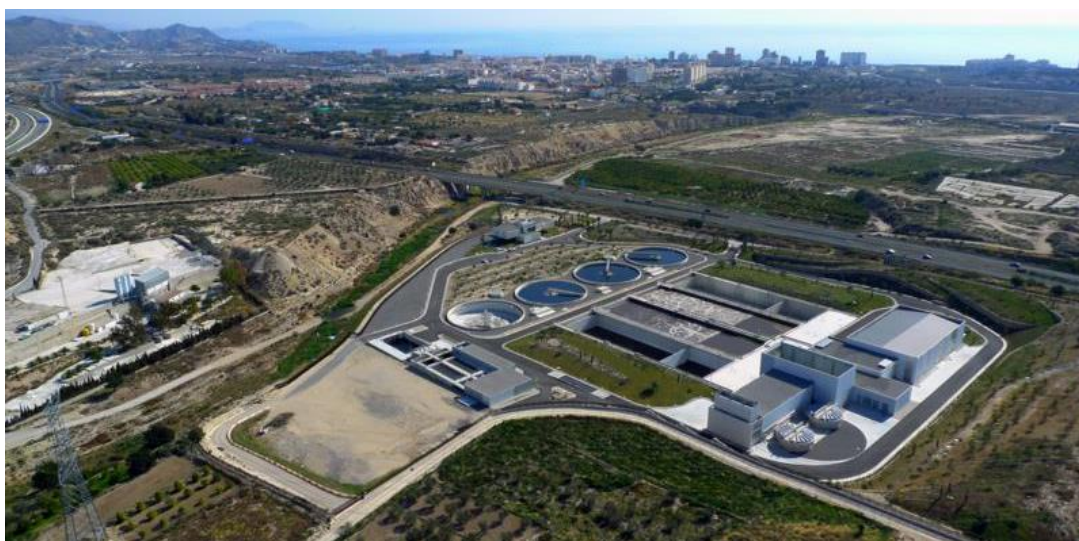
Figura 11: Estación Depuradora de Aguas Residuales (EDAR) Alacantí Norte, junto a ella el cauce del río Seco (Fuente: inimia.es).
