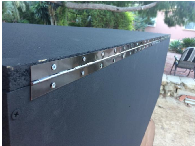
Figura 5. Fijación de la puerta con dos bisagras de piano de 90cm.
