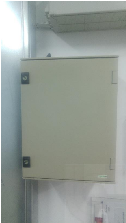
Cuadros eléctricos sin señalizar. Foto propia.
