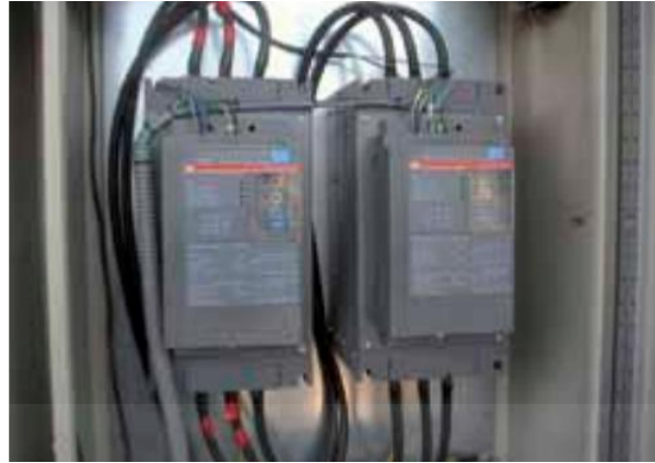
Figura 25. Ejemplo de arrancadores estáticos (Abadía et al., 2008).
