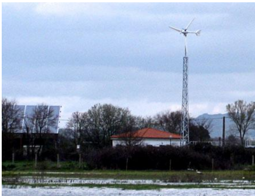
Figura 10. Aerogenerador de una de las EDAR de Ourense (Ourense) (Energética XXI, 2013).
