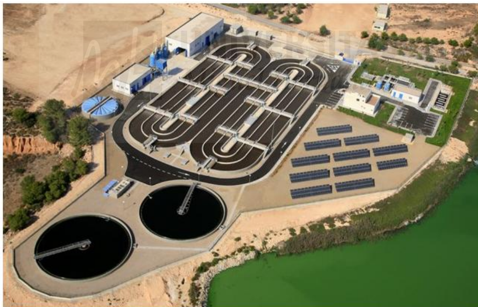
Figura 8. Placas Solares en la EDAR de Pilar de la Horadada (Alicante) (EPSAR, 2015).
