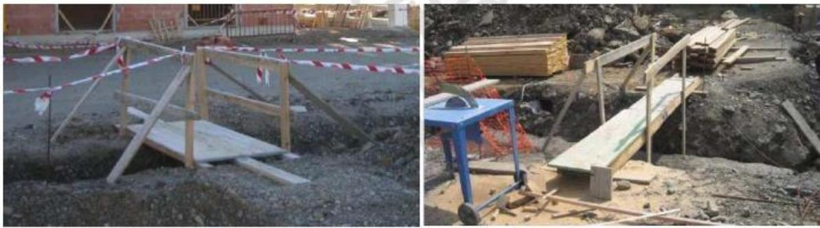
Y especial cuidado en los medios de paso, en caso de que puedan acceder peatones (interferencia con terceros). Para prevenir la caída de materiales deben mantenerse a una distancia prudencial del borde de la excavación, para evitar su caída a la misma.
