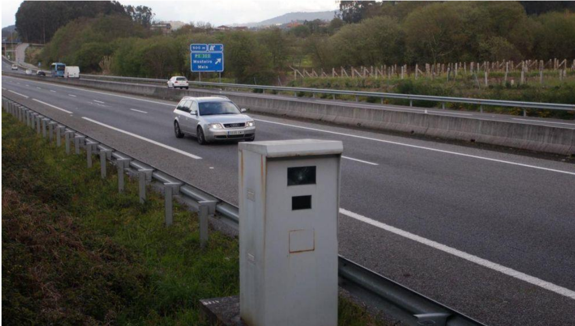
Ilustración 1: Radar de carretera que monitoriza la velocidad de los vehículos
