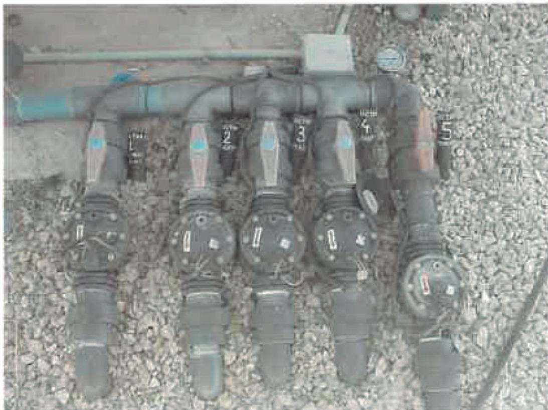
**Fotografía n° 11. Cabezales de distribución automática de riego por zonas**
