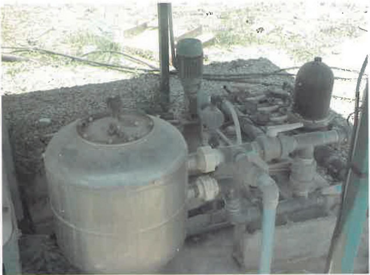
**Fotografía n° 9. Filtros y bomba inyectors de una cabeza de riego.**
