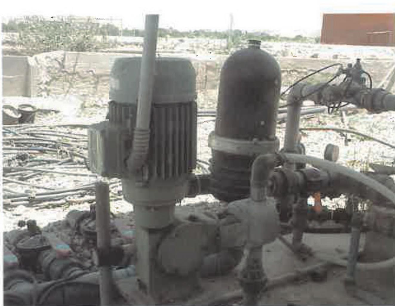
**Fotografía n° 10. Bomba dosificadora de fertirrigación.**
