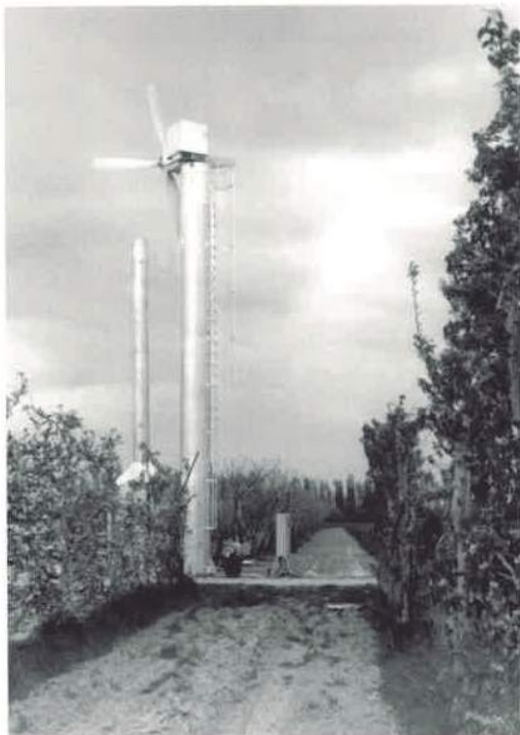
Fotografía 2. Torre de viento con estufa.
