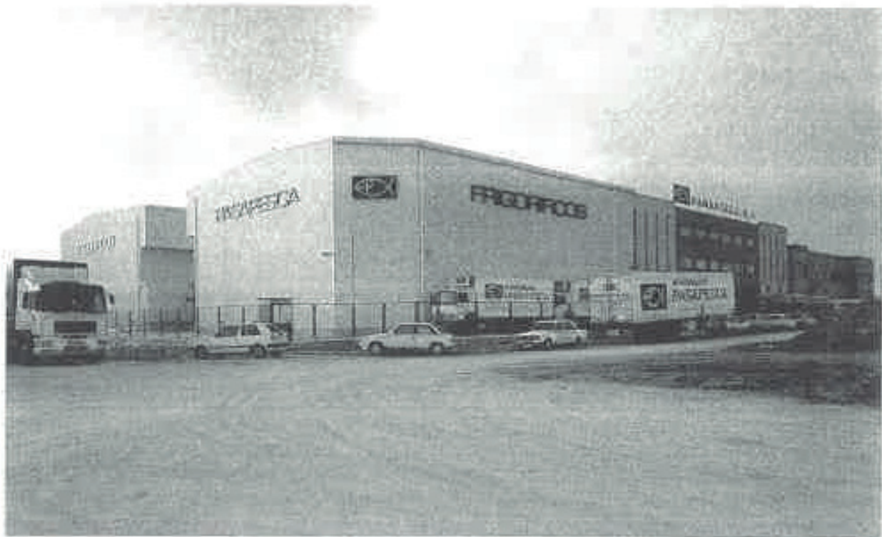
Foto 30. Cámaras frigoríficas para almacenamiento de pescado congelado con capacidad total de 27.000 m 3 . Realización de Ingeniería del Frío, S.A. (INFRISA)
