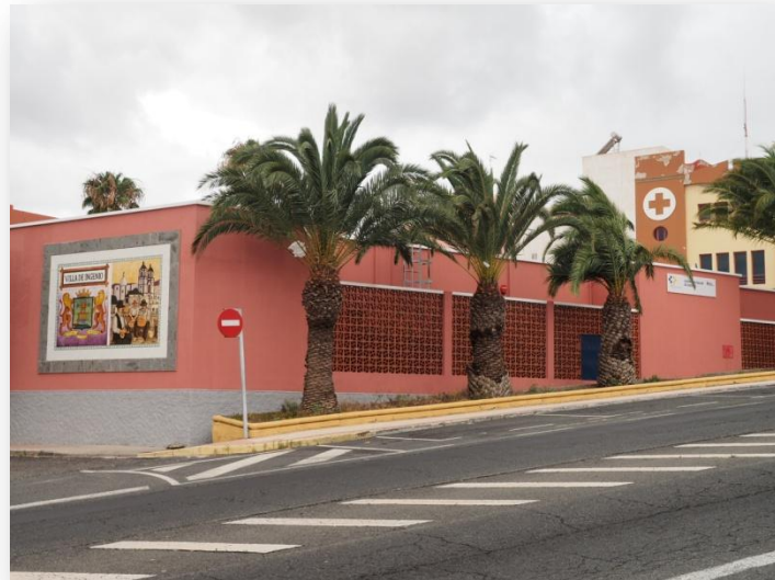
Ilustración 17. Centro de Salud de Ingenio. Fuente: Elaboración propia.
