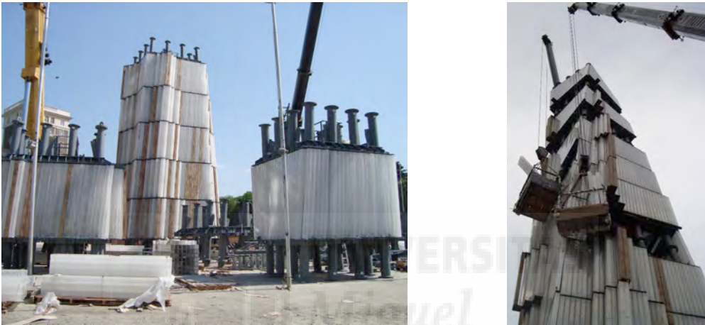
Figs. 779, 780: Montaje de la obra Heroe Tower .
