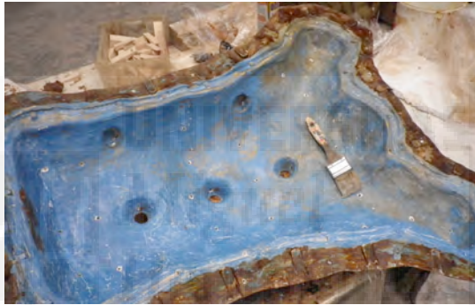
Fig.635: Perforación de la carcasa para la realización de respiraderos y entradas.
