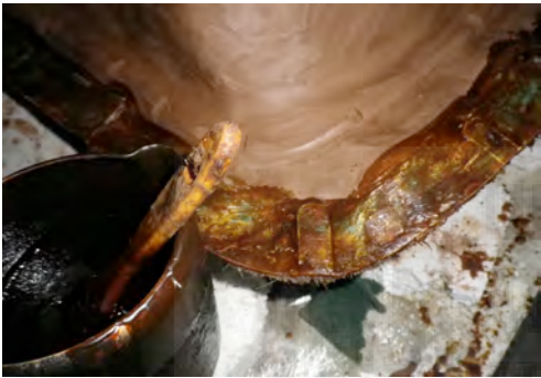
Fig.629: Aplicación de cera en el borde de la carcasa para evitar la adherencia de la nueva resina. Fig.630: Realización de la segunda carcasa de fibra de vidrio y resina de poliéster.
