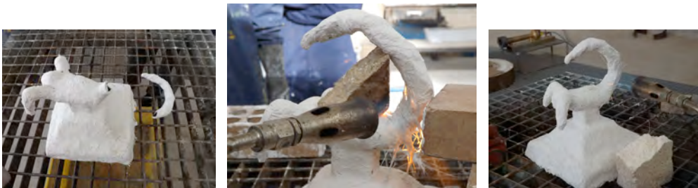
Figs. 201, 202, 203: Reparación de una cascarilla con fibra de vidrio.
