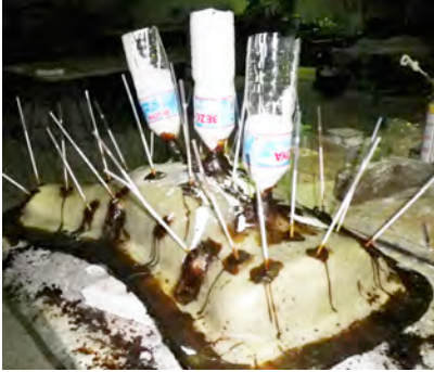
Fig.639: Vertido de la silicona de la primera membrana.
