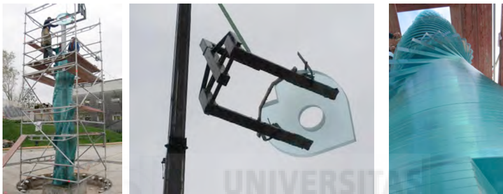
Figs. 775 - 777: Montaje de la obra Rain Hearts .
