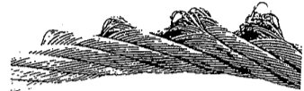
Cliché 12 - Agravación del defecto anterior en un grado que justifica la retirada inmediata del cable.
