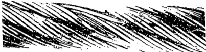
Cliché 3 - Roturas de alambres en un mismo cordón asociadas a un ligero desgaste. Justifica una operación posterior en el eje de la correa o condición rotura de alambres al ras de la boya si el cable puede seguir en su uso posterior a un "uso autorizado".
