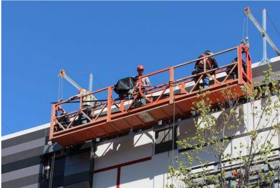
Imagen 25. Plataforma suspendida de nivel variable o andamio colgado. (Autor)
