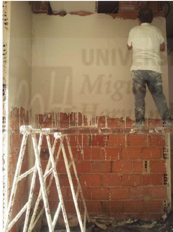
Imagen 432. Yesaire trabajando sobre andamio de borriquetas. (Autor)
