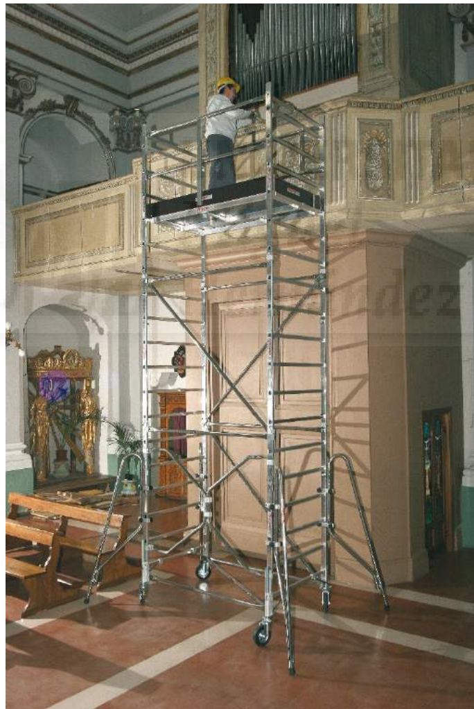
Imagen 10. Operario realizando trabajos de mantenimiento sobre andamio móvil con ruedas. (Catálogo FARAONE)
