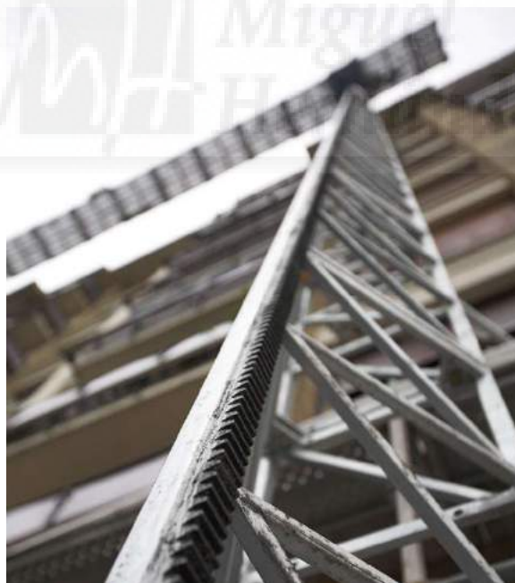
Imagen 1. Cremallera del andamio y mástil. ( www.andamiosduar.com )
