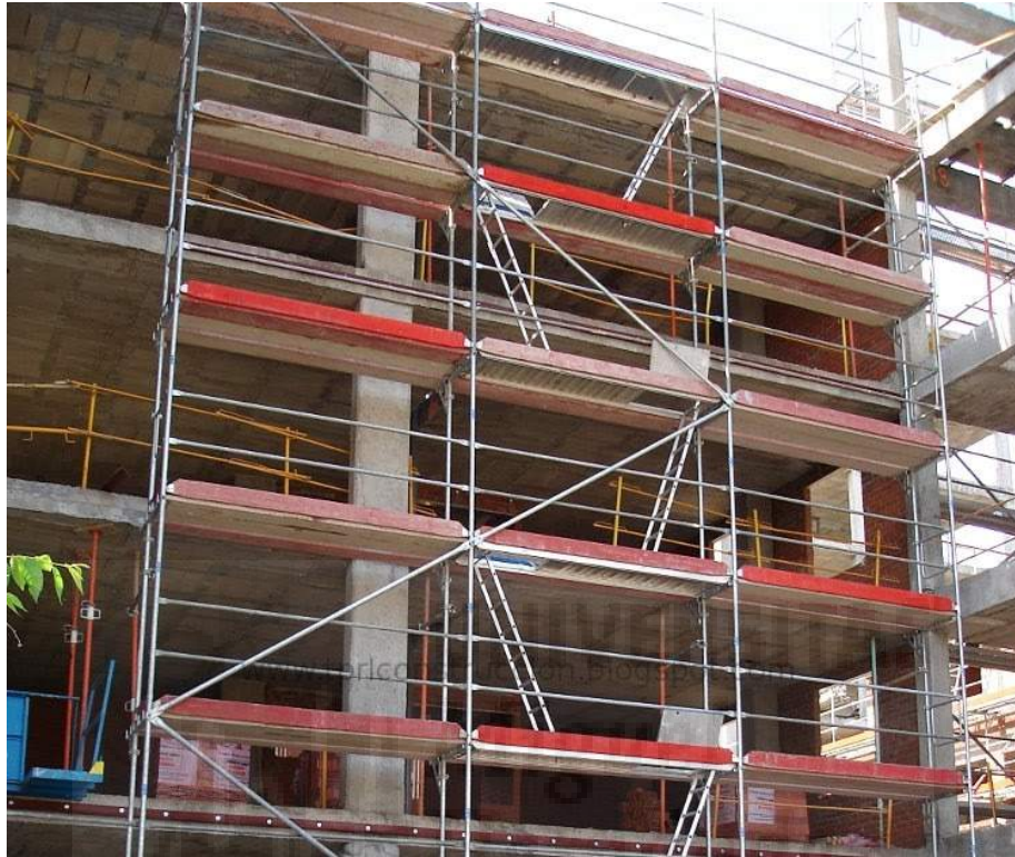
Imagen 14. Andamio con configuración tipo, no necesita hoja de cálculo. (Autor)
