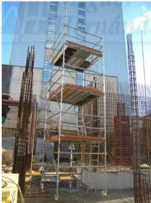
Imagen 16. Andamio móvil con ruedas provisto de varias plataformas. (Autor)
