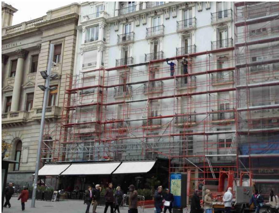
Imagen 12. Trabajadores en tareas de montaje de andamio tubular en fachada. ( www.construmatica.com )
