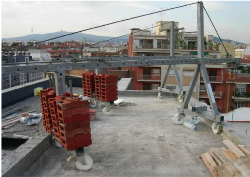
Imagen 26. Pescantes para andamio colgado provistos de contrapesos. (Catálogo MACLOGUER)
