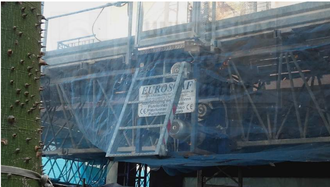
Imagen 11. Placa identificativa con marcado CE. (Autor)
