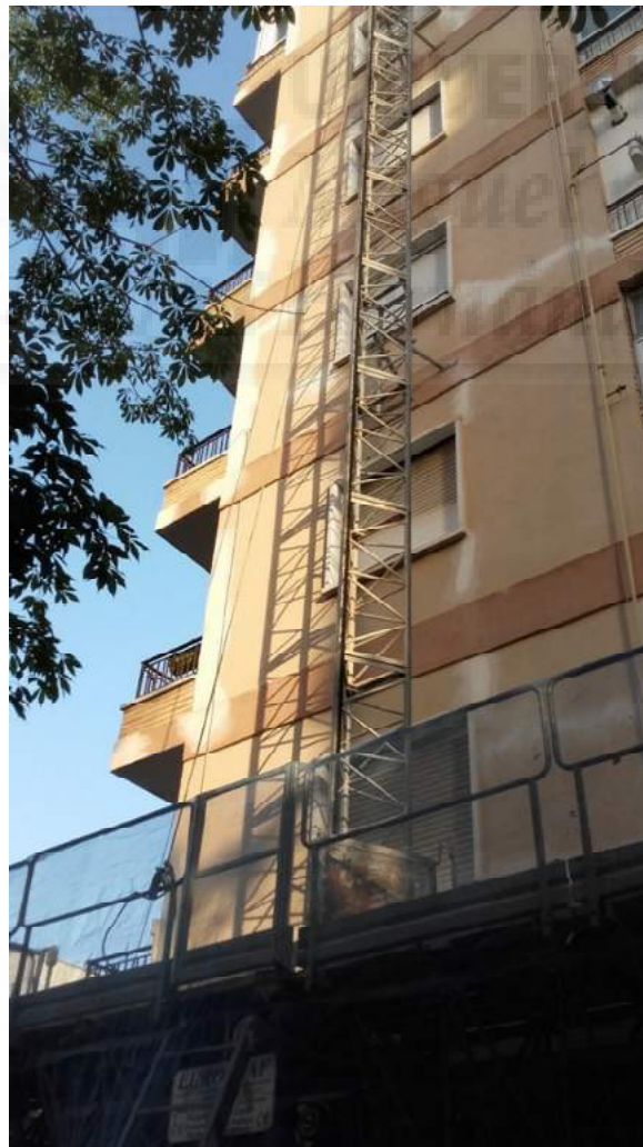
Imagen 22. Plataforma de trabajo con barandillas de protección perimetrales. (Autor)
