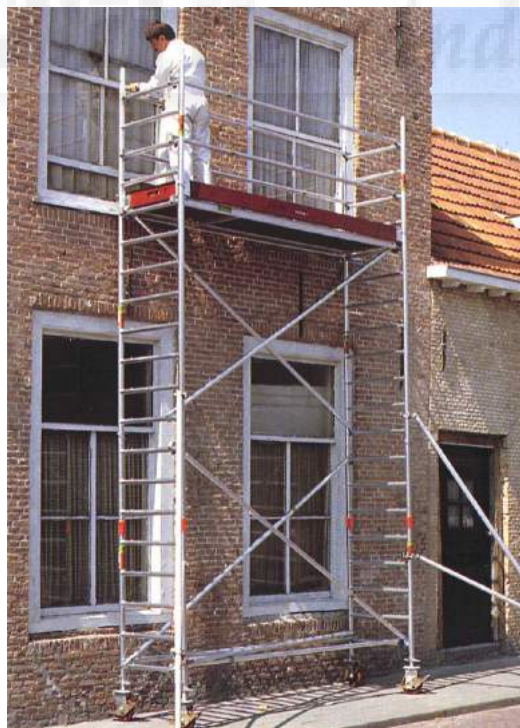
Imagen 9. Trabajador sobre andamio móvil con ruedas. (Autor)
