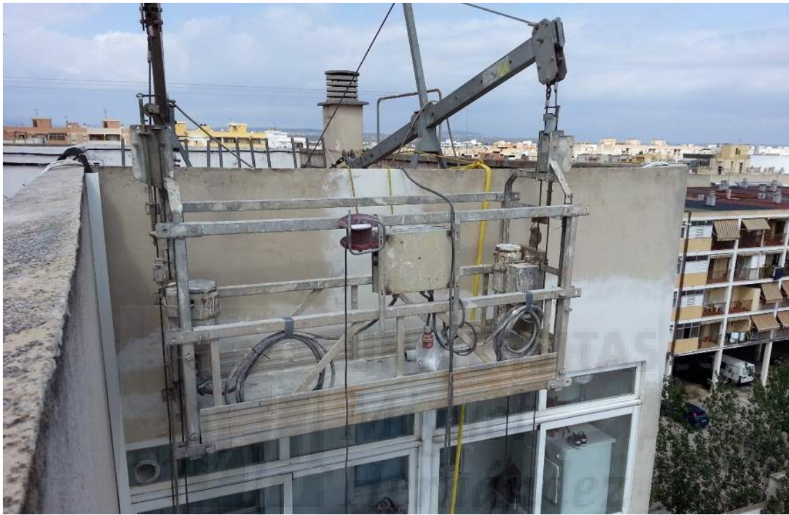
Imagen 5. Andamio colgado de accionamiento motorizado. (Autor)
