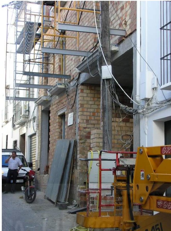
Imagen 13. Andamio instalado evitando la ocupación de la acera. ( www.construmatica.com )
