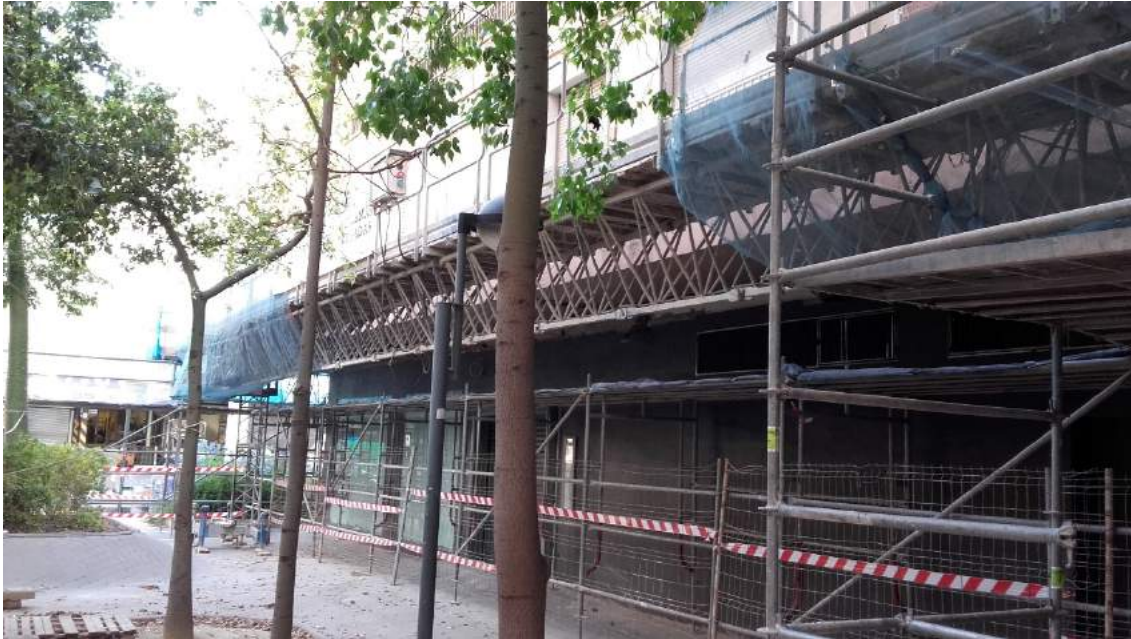
Imagen 23. Protección de la zona bajo la plataforma mediante vallas de seguridad. Acceso restringido. (Autor)
