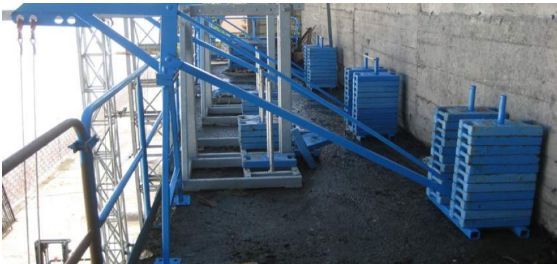
Imagen 27. Pescantes con doble cable con gancho de seguridad y cables perpendiculares al suelo. (www.alba.es)
