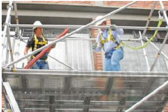
Imagen 158. Operarios llevando a cabo trabajos en condiciones óptimas de seguridad. ( www.construmatica.com )
