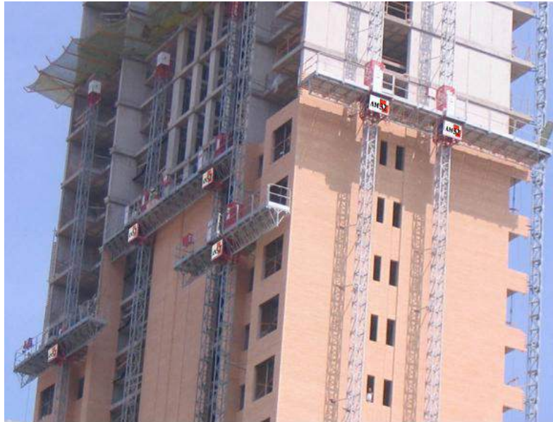
Imagen 15. Plataformas de trabajo sobre mástil trabajando de forma simultánea. (www.sacmaquinaria.com)
