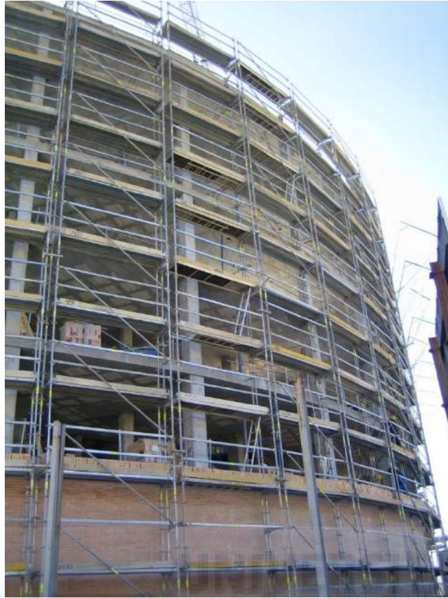
Imagen 7. Andamio tubular sobre fachada curva. ( www.lineaprevencion.com )
