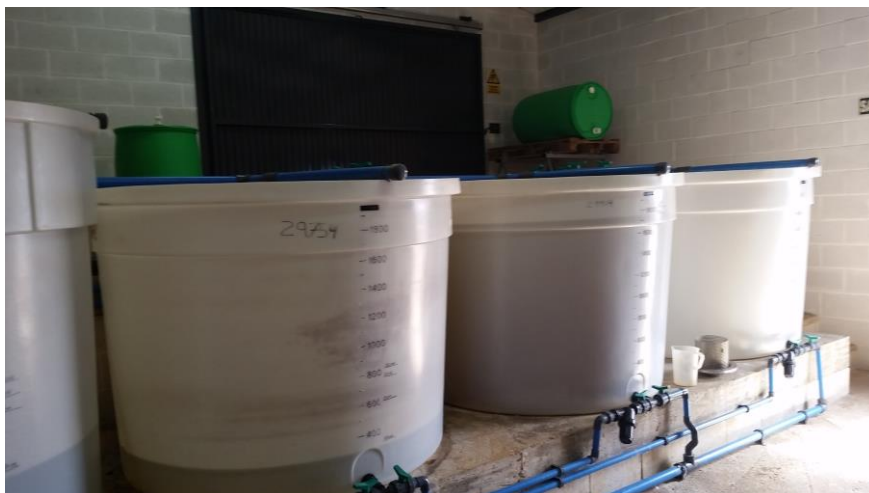
Depósitos para distribuir el abono a través del sistema de riego.
