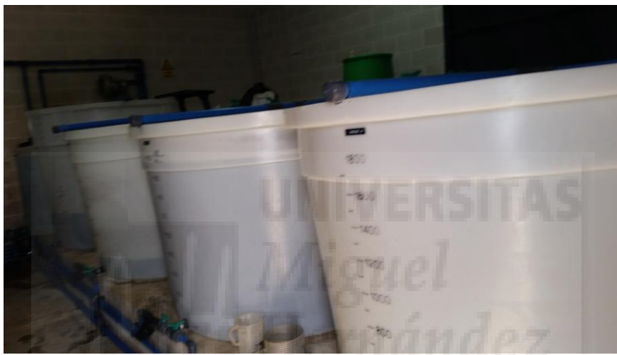
Depósitos para distribuir el abono a través del sistema de riego.
