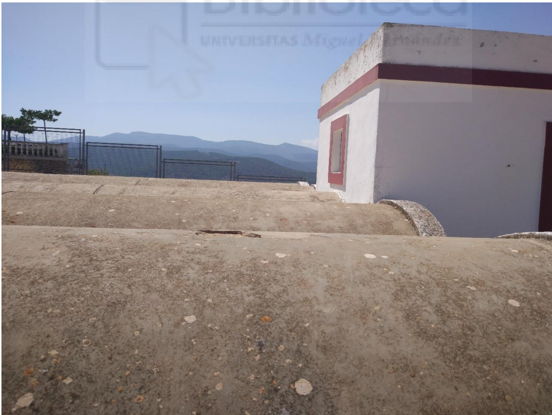
Fotografía 9. Adecuación de la caseta de acceso al depósito 1.
