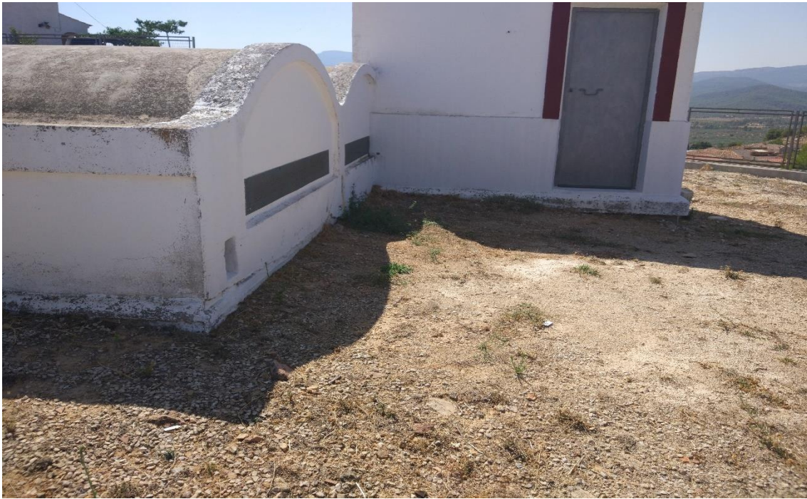
Fotografía 2. Ubicación de un tramo de acera perimetral
