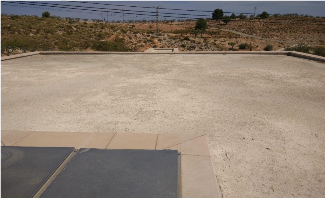
Fotografía 10. Realización de hueco para puerta para acceso al depósito 2.
