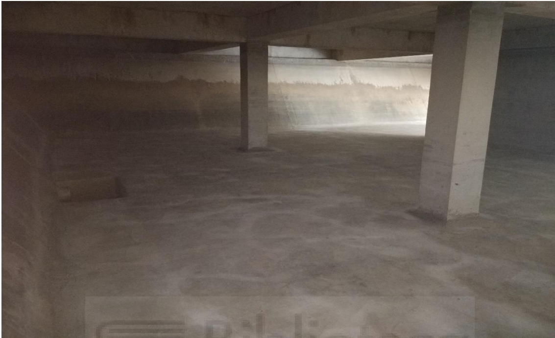
Fotografía 3. Solera de depósito hormigonado.
