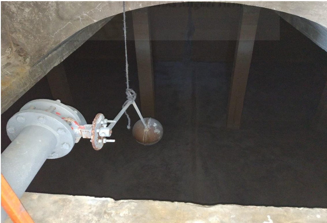
Fotografía 12. Ubicación de la escalera para acceso al depósito 1.
