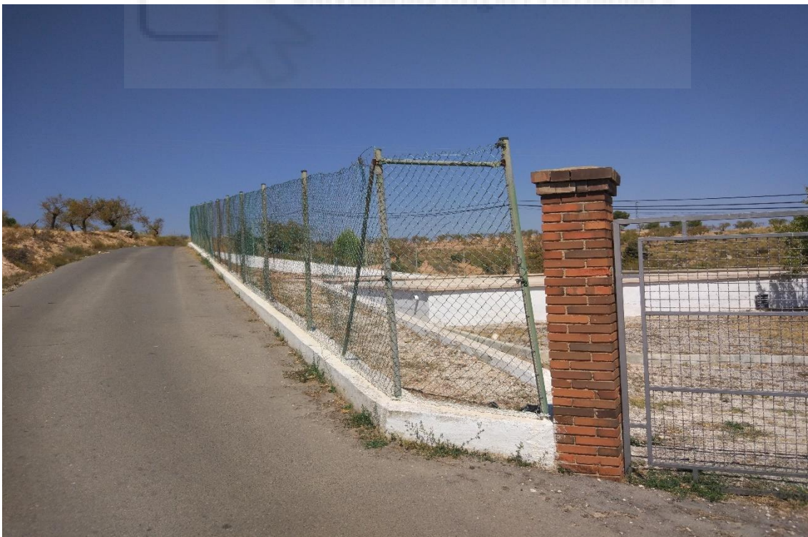
Fotografía 4. Muro de hormigón perimetral
