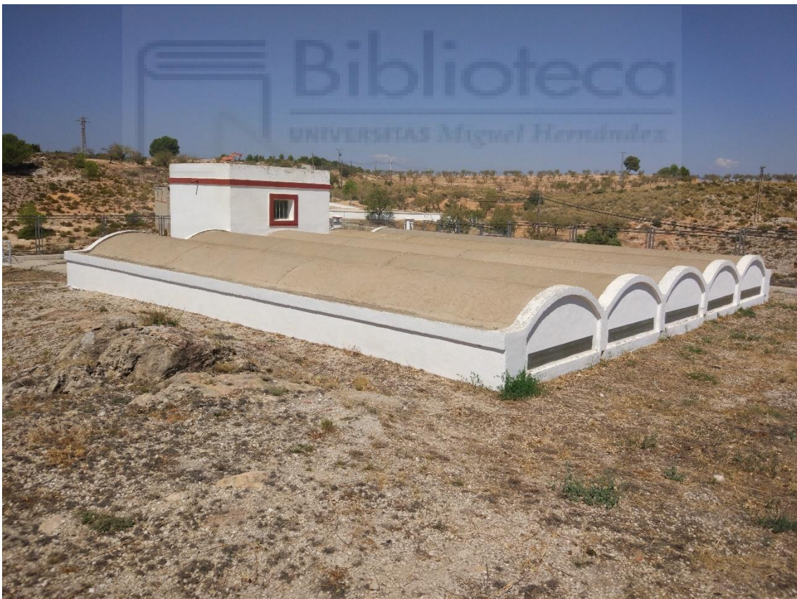
Fotografía 11. Cubierta a impermeabilizar.
