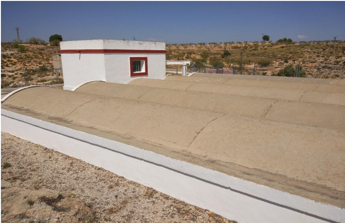
Fotografía 13. Trabajo en altura para la impermeabilización de la cubierta y adecuación de la caseta.
