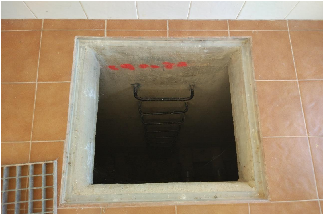
Fotografía 8. Amplitud de hueco para colocación de reja y sustitución de pates.
