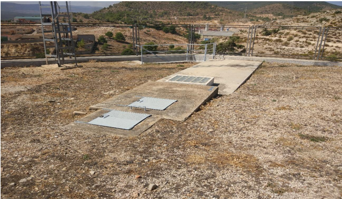
Fotografía 15. Tramo de acera perimetral
