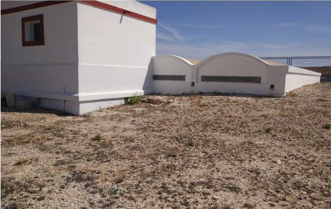
Fotografía 5. Zona de acera perimetral de 1 metro de ancho.
