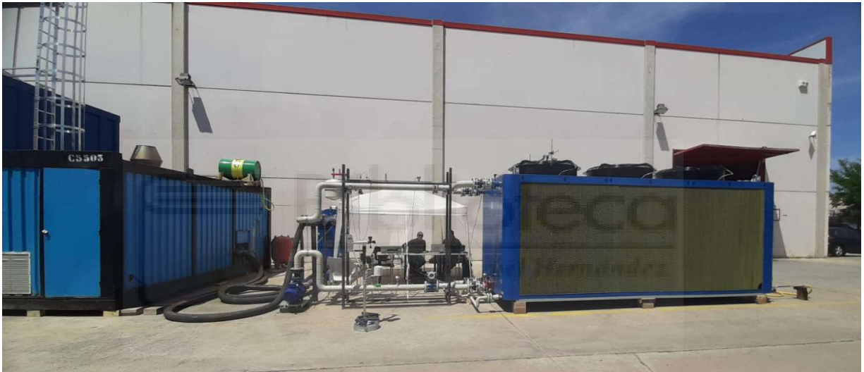
Figura 4.1: Disposición del despliegue durante los ensayos.
