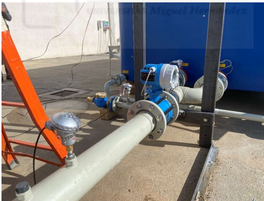
Figura 4.8: RTD a la salida del circuito primario.
