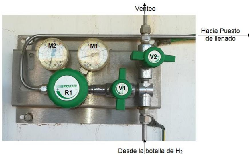
.Del regulador de presión (R1) sale una tubería hacia el puesto de llenado que dispone también de elementos de control y regulación de presión de trabajo.
