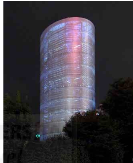
Toyo Ito, Torre de los Vientos , (1986).
