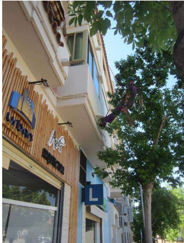
Fotografía. Condiciones adversas por existencia de arbolado en trabajos verticales.
