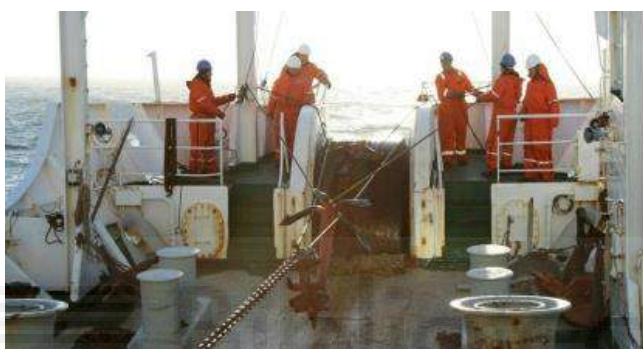
Figura 1. Reparación de un cable submarino [3]
