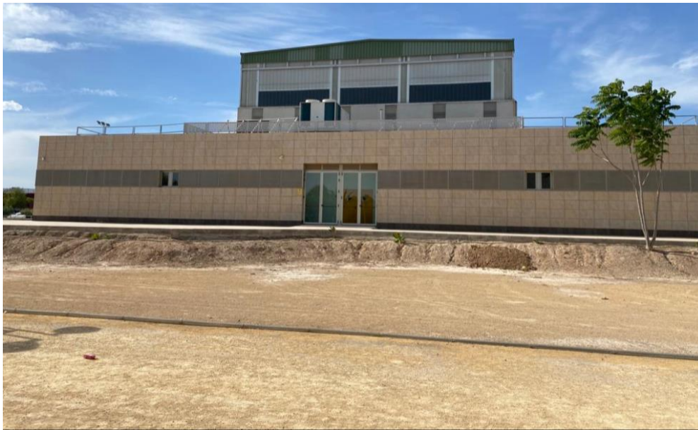
Figura 8: Fotografía frontal de la situación actual
