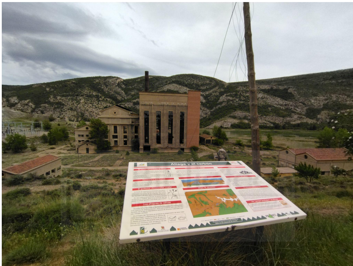
Vista del exterior de la central térmica desde un mirador
