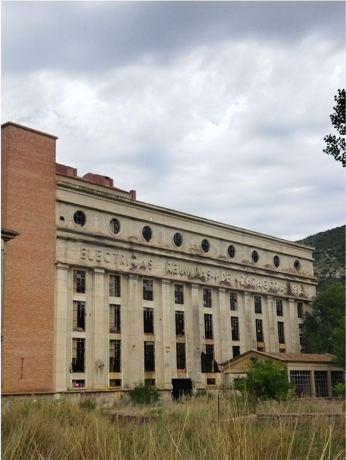
Fachada de la central térmica donde se lee el nombre de la compañía ERZ
