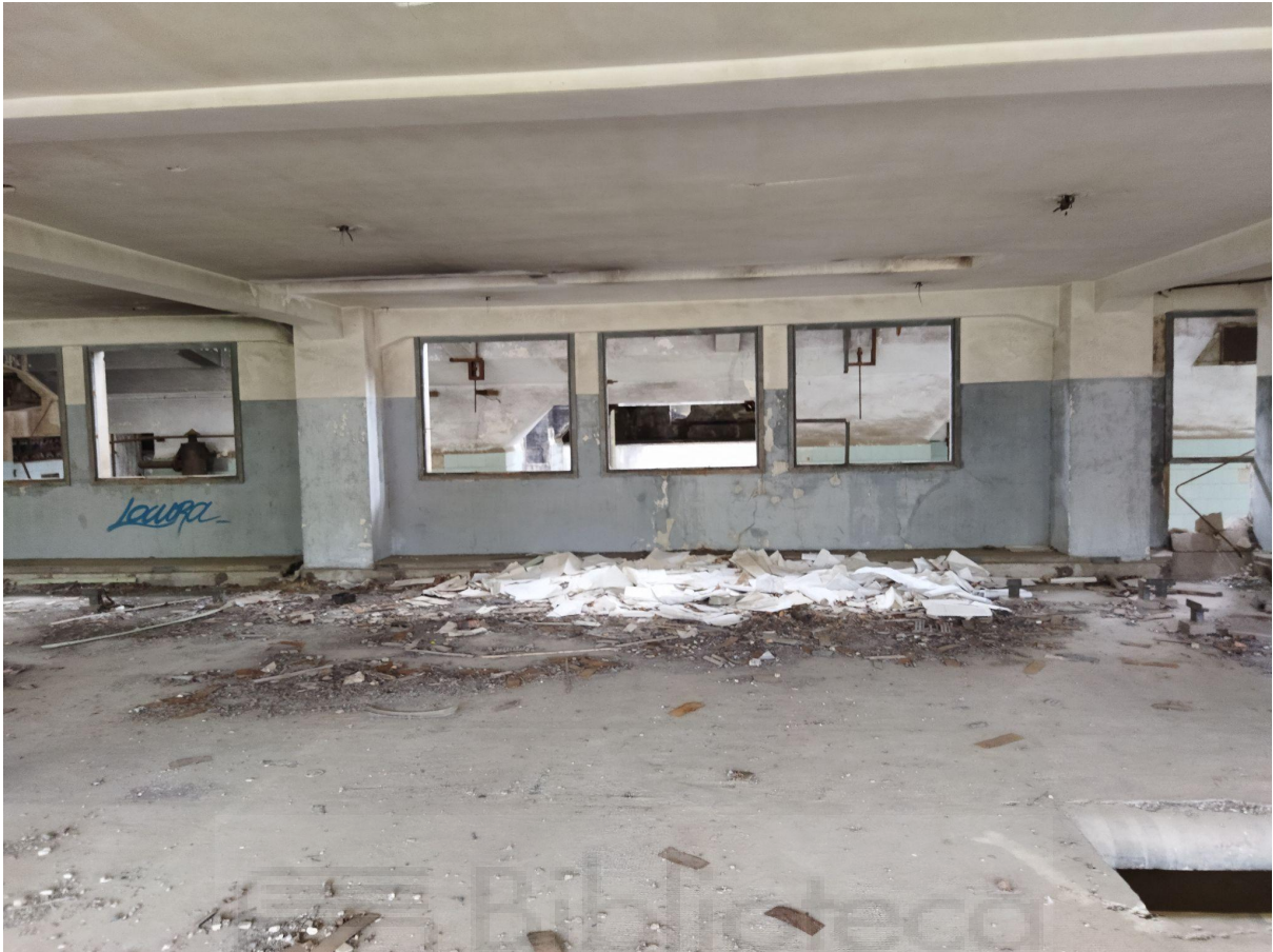
Restos de las antiguas oficinas
