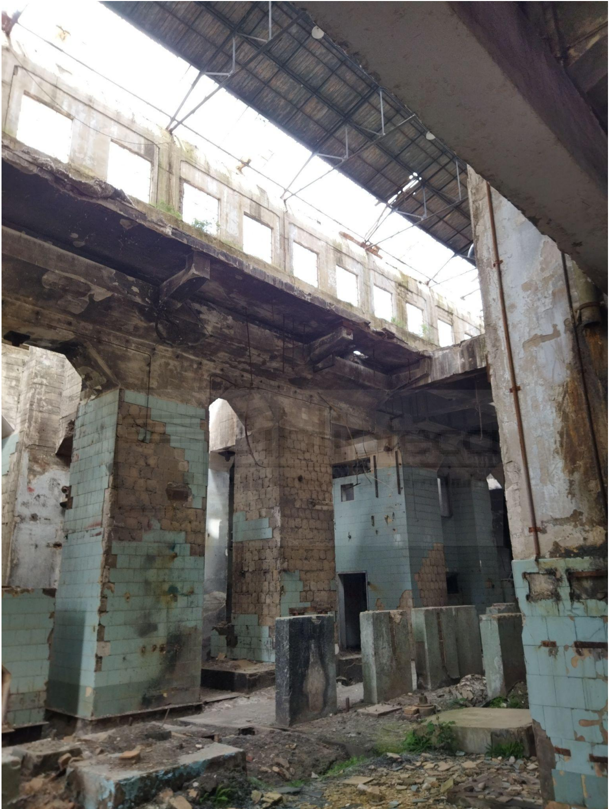
Interior abandonado de la central térmica
