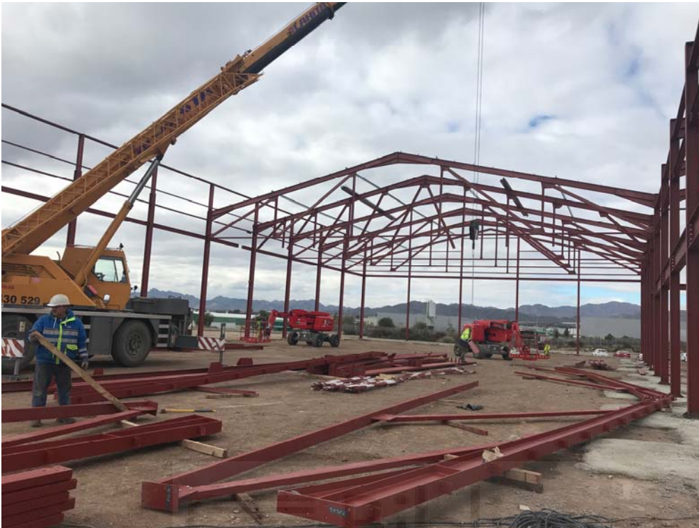
Foto del montaje de la estructura metálica de la nave.
