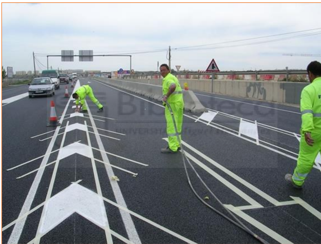
ILUSTRACIÓN 7. EJECUCIÓN DE SEÑALIZACIÓN Y BALIZAMIENTO (FUENTE: EMPRESA INDUSTRIAS SALUDES)
