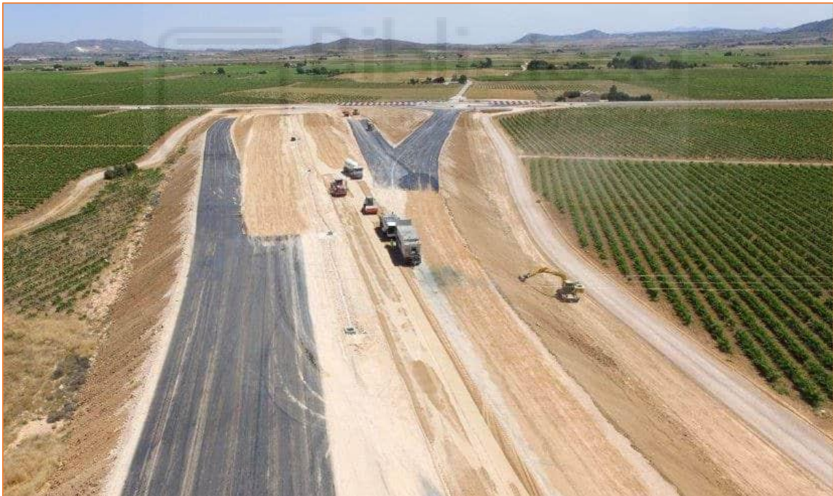
ILUSTRACIÓN 3. TRABAJOS DE EJECUCIÓN DE EXPLANACIÓN Y ASFALTADO DE LA AUTOVÍA A-33. CIEZA-FUENTE DE LA HIGUERA.
