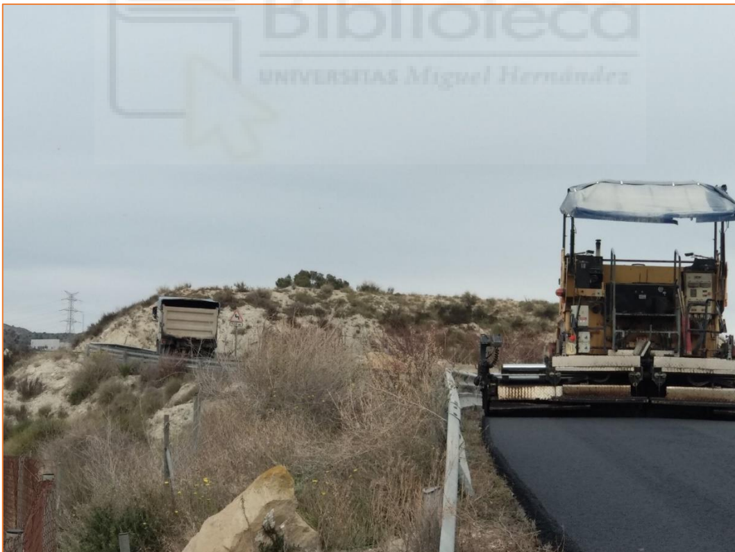
ILUSTRACIÓN 6. EJECUCIÓN DE FIRME DE MEZCLA BITUMINOS EN CAMINOS RURALES (FUENTE: ELABORACIÓN PROPIA)
