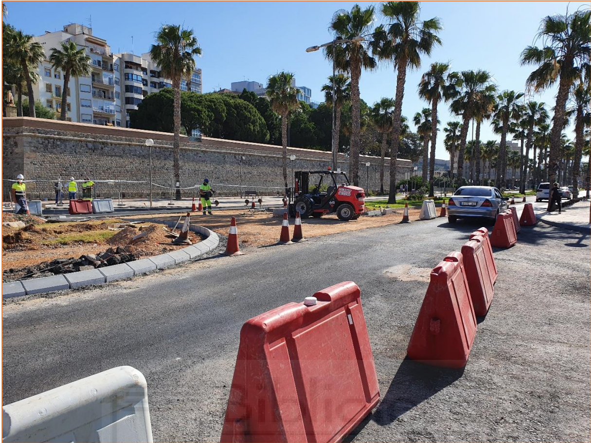
ILUSTRACIÓN 20. BALIZAMIENTO Y DESVIOS EN OBRAS EN CARRETERAS. (FUENTE: ELABORACIÓN PROPIA)
