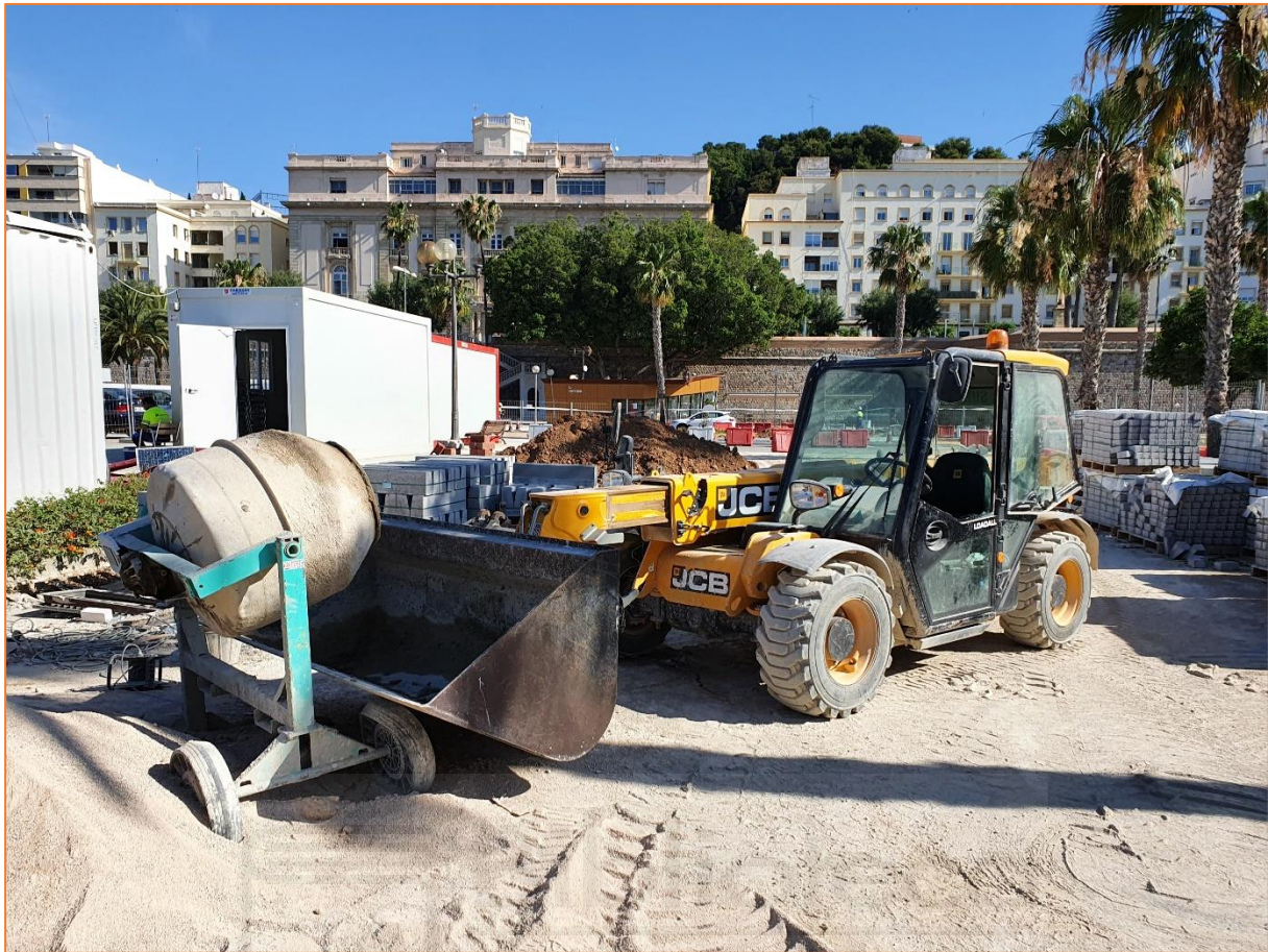
ILUSTRACIÓN 17. ZONA DE ACOPIO DE MATERIAL E INSTALACIONES EN OBRAS DE CARRETERA (FUENTE: ELABORACIÓN PROPIA)
