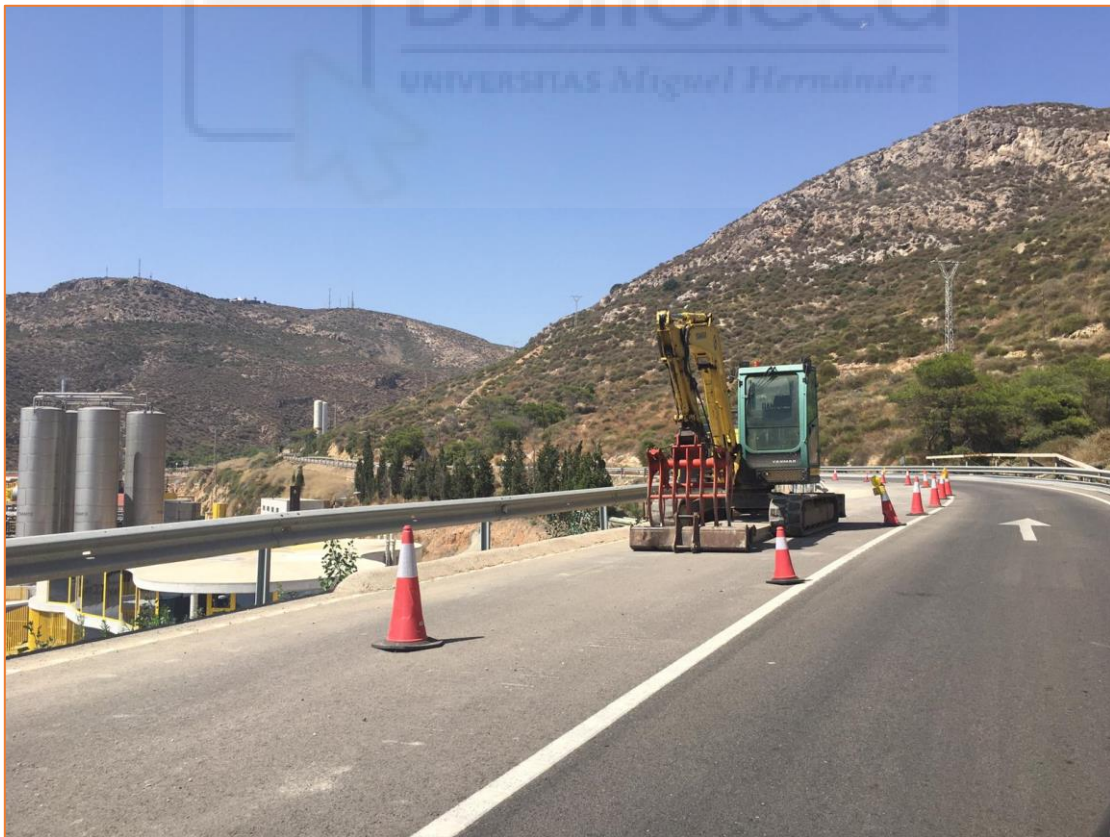
ILUSTRACIÓN 12. OBRA DE MANTENIMIENTO DE TALUDES EN CARRETERAS (FUENTE: ELABORACIÓN PROPIA)
