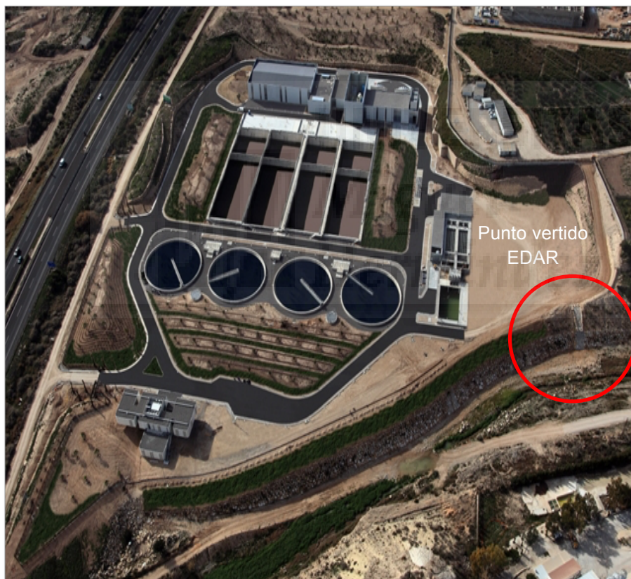
Figura 4. EDAR Alacantí Norte (Imagen tomada de EPSAR, 2014)
