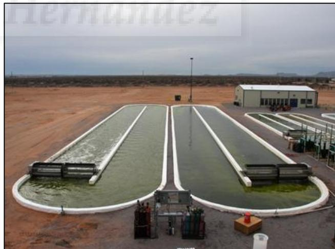
Figura 3. Sistema de estanques abiertos en Sapphire Energy's Las Cruces, Nuevo México (Algae basics-All About Algae).
