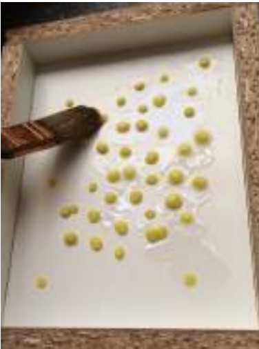
Imagen 156. Aplicación de desmoldeante
