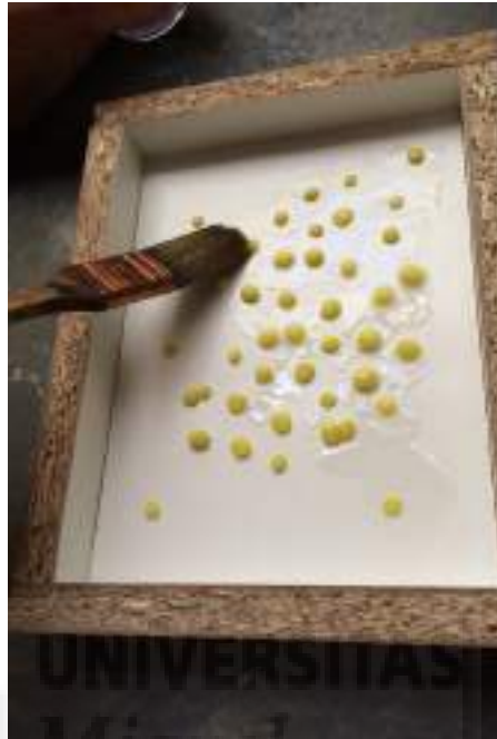
Imagen 131. Aplicación separador de moldes
