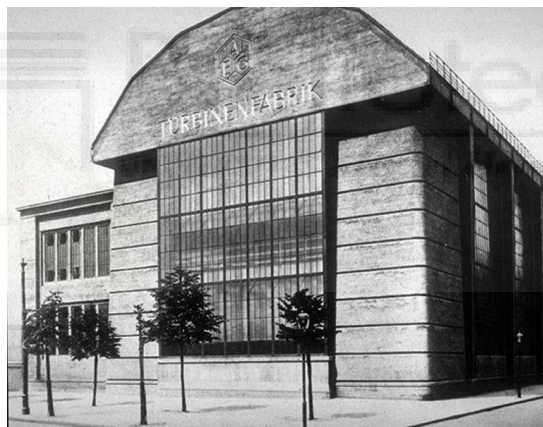
Figura 6: Sala de Turbinas de Peter Behrens. Fuente: historico.oepm.es . La sala de turbinas destaca por ser uno de los primeros edificios funcionales en Alemania, y ser la primera en poseer una pared cortina realizada con cristal.
