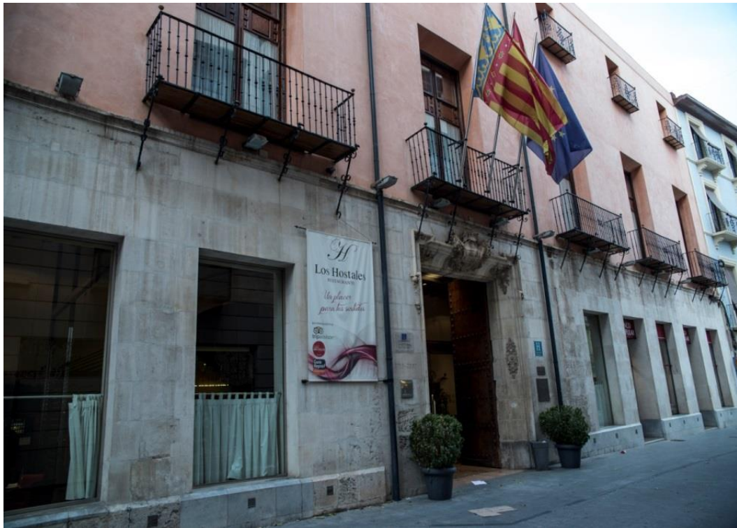
Fotografía 81. Perspectiva del Bar del Hotel Palacio Tudemir y entrada. Diciembre 2014.
