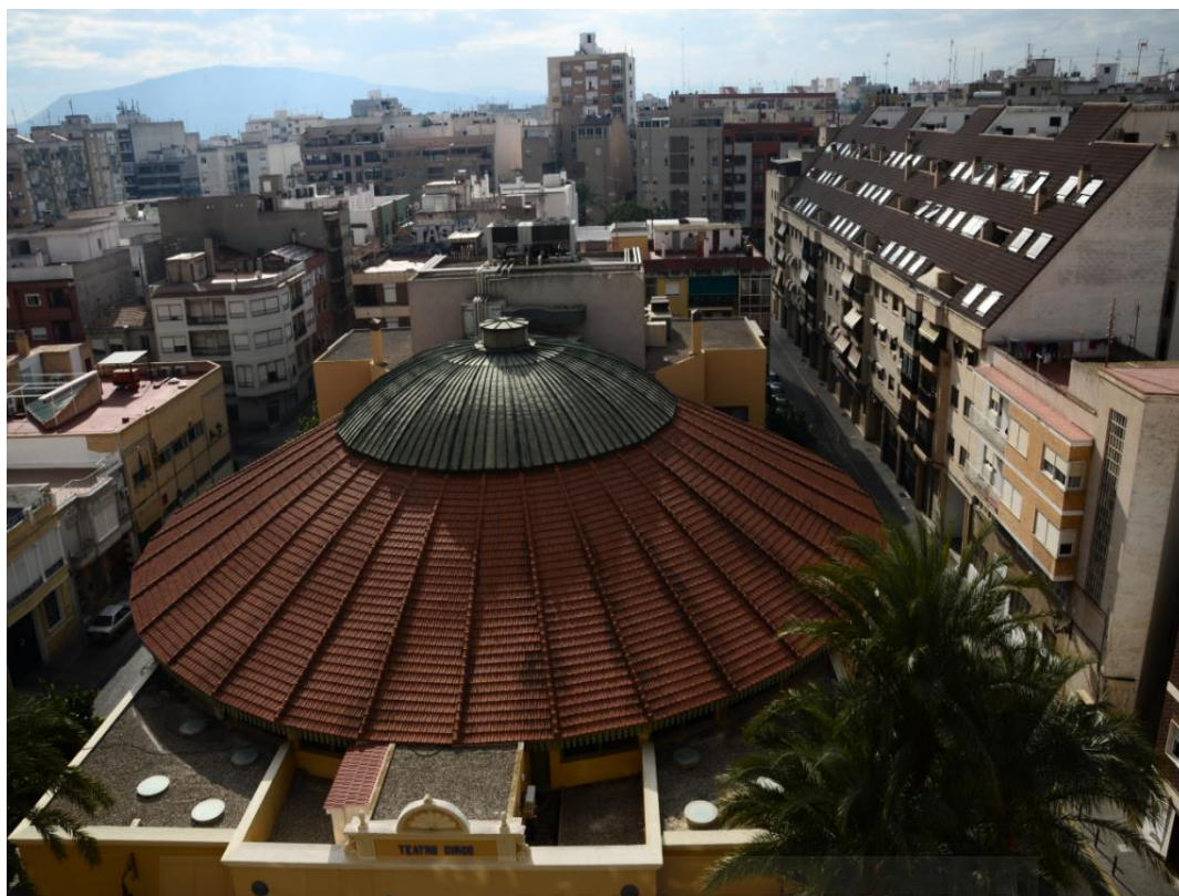
Fotografía 31. Cubierta Teatro Circo. Diciembre 2014.
