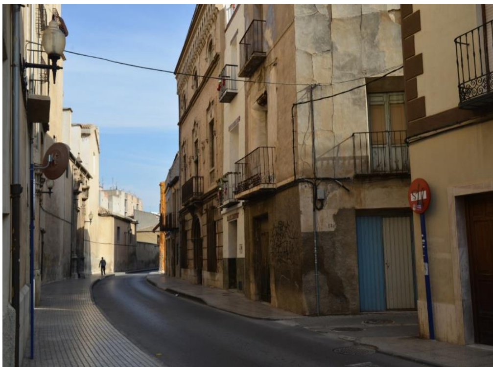
Fotografía 105. Mal estado de viviendas frente al Convento de las Clarisas, en Calle San Juan, colindante al Centro Histórico. Diciembre 2014.
