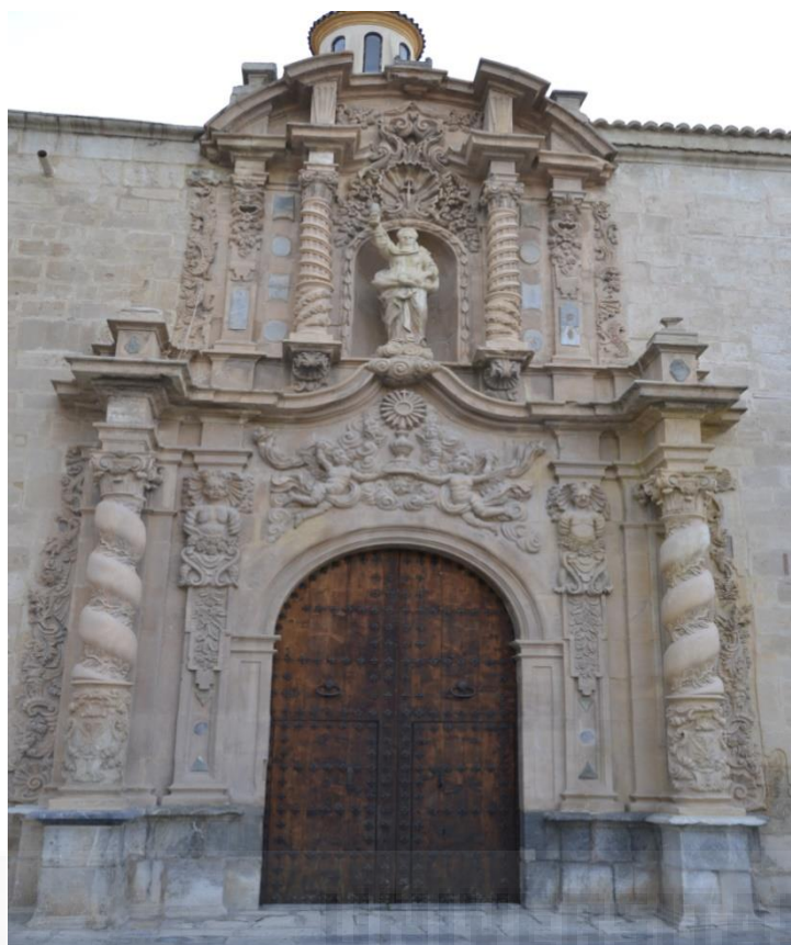
Fotografía 35. Puerta lateral. Diciembre 2014.
