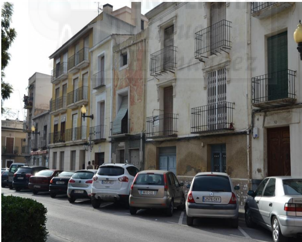
Fotografía 110. Estado de las viviendas en Plaza de Monserrate, en pleno Centro Histórico. Diciembre 2014.
