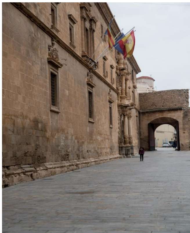
Fotografía 49. Fachada Colegio Santo Domingo. Al fondo, portada interior de la Puerta de la Olma. Diciembre 2014.
