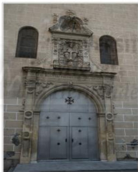
Fotografía 65. Puerta principal de la iglesia de la Santísima Trinidad. Junio 2015.
