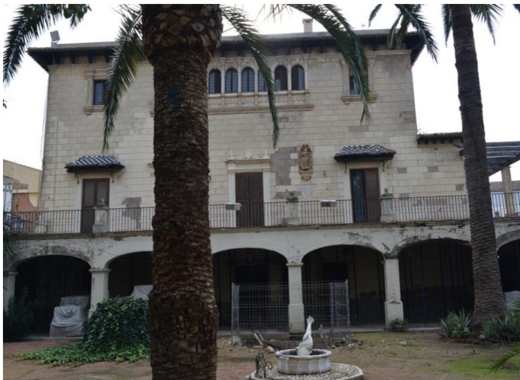
Fotografía 8. Palacio de Rubalcava de propiedad municipal.
