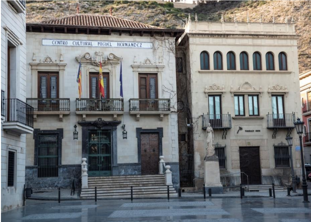
Fotografía 136. A la izquierda se observa un balcón de la Biblioteca Pública Fernando de Loazes, y al fondo de la fotografía, el Centro Cultural Miguel Hernández, antiguo conservatorio de la ciudad y sede de la Caja de Ahorros de Nuestra Señora de Monserrate; a su lado se ubicaba hace pocos años el Tourist Info . Diciembre 2014.
