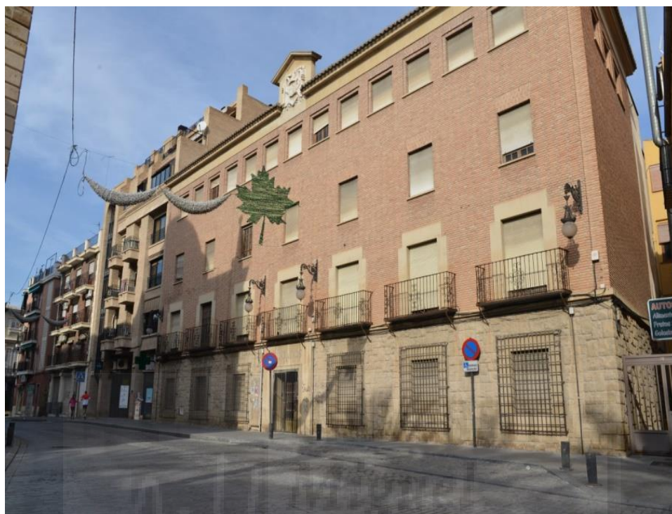
Fotografía 22. Fachada antiguos Juzgados de Orihuela a diciembre de 2014.
