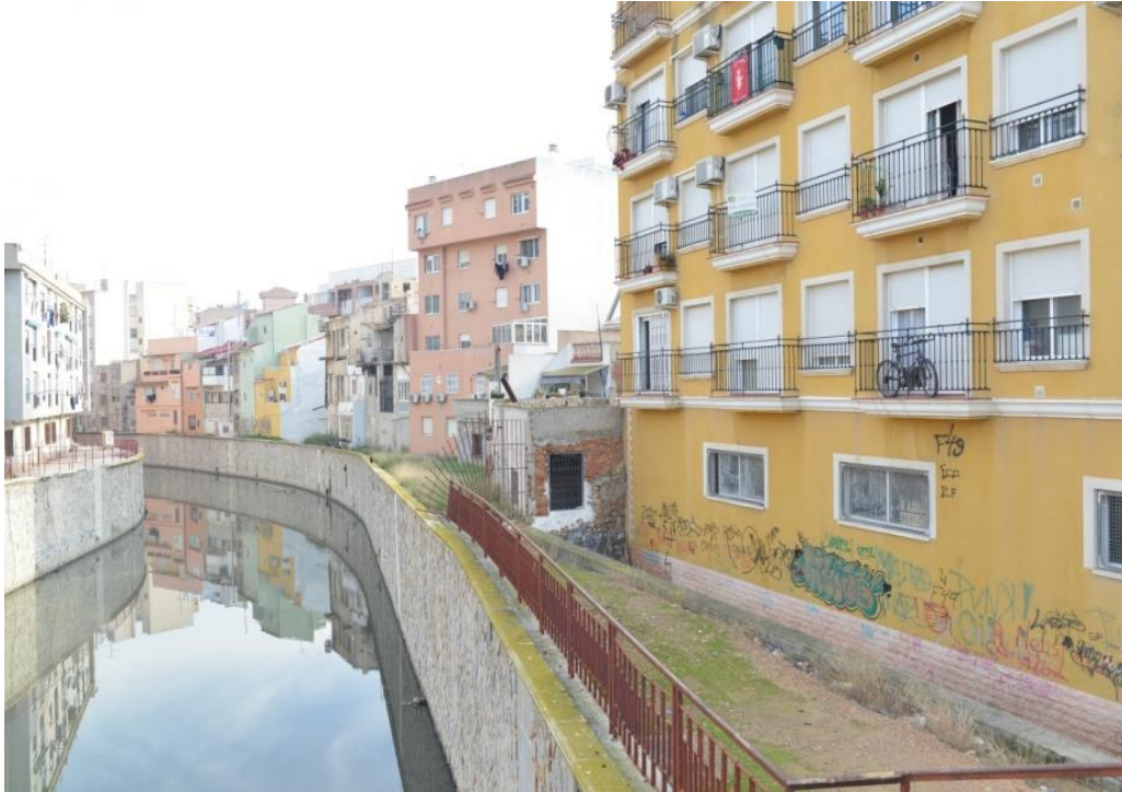
Fotografía 123. Estado de la fachadas a la derecha del río Segura, frente a la UMH y en pleno Centro Histórico de Orihuela. Diciembre 2014.
