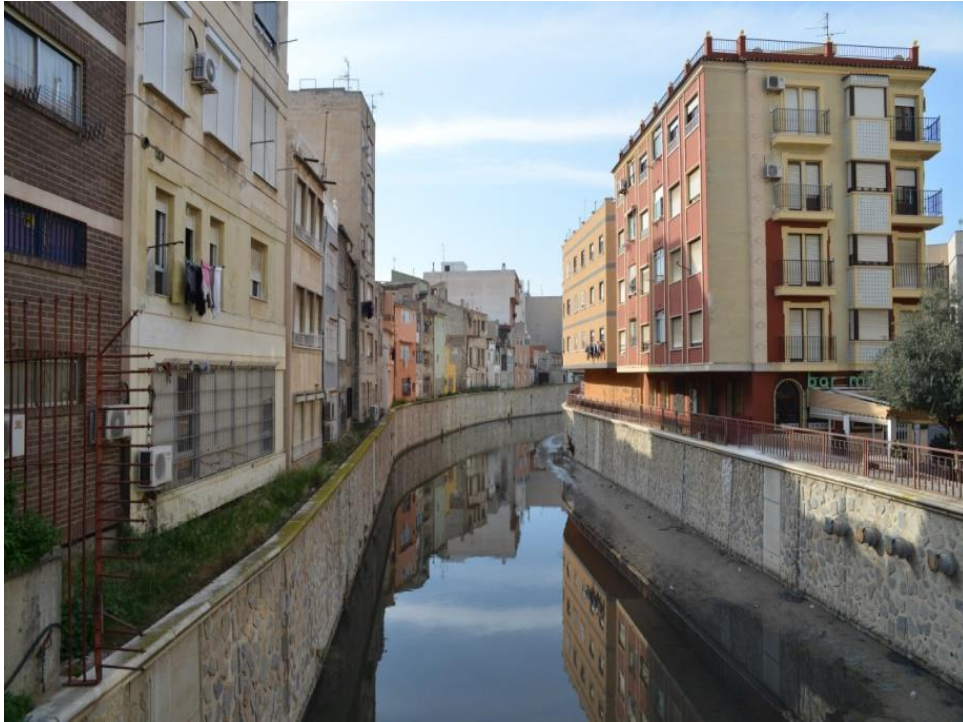
Fotografía 109. Estado de las fachadas a la izquierda del río desde el Puente de Poniente. Próximas a la UMH y en pleno Centro Histórico. Diciembre 2014.
