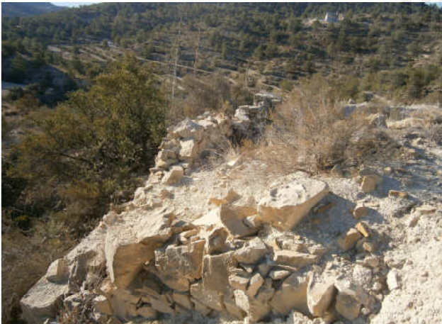
Ilustración 24: Construcción C. Foto de las ruinas.
