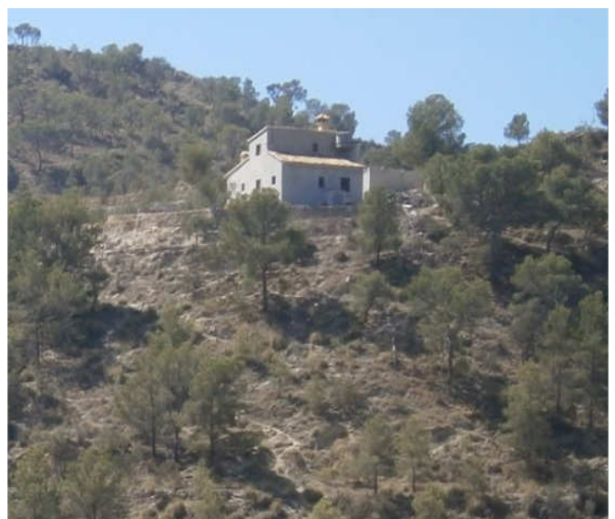
Ilustración 18: Construcción A. Foto in situ.
