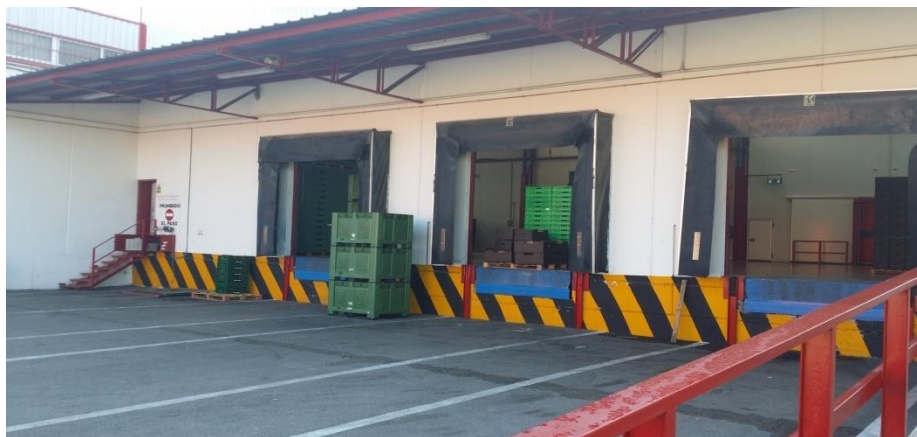
Figura 22. Muelles de descarga para la expedición de cítricos (elaboración propia).
